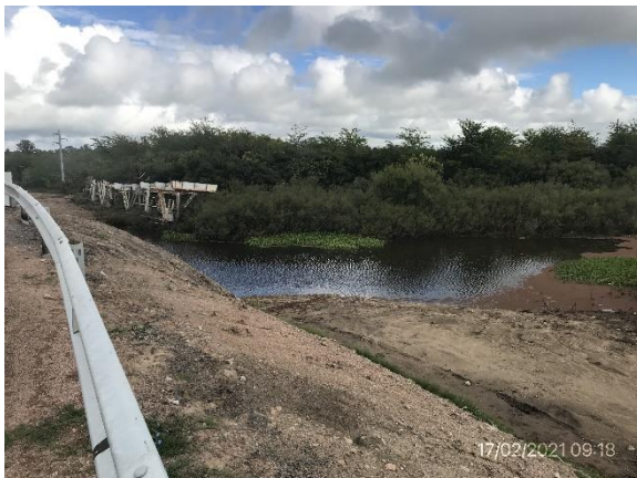
Ilustración 6 – P01, Puente sobre Aº Agua Sucia terminado. Taludes en cuartos de cono conformados.
