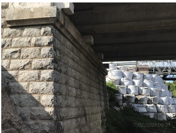
Ilustración 8 – P01, Estribos reutilizados para nuevo puente sobre Aº Agua Sucia.
