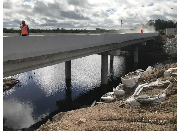
Ilustración 5 – P01, Puente sobre Aº Agua Sucia terminado.
