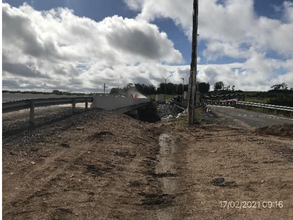
Ilustración 4 – P01, Puente sobre Aº Agua Sucia y campamento provisional desmontado.
