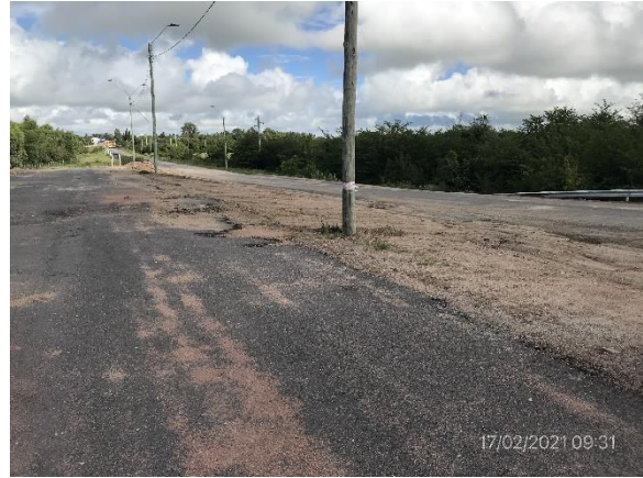
Ilustración 11 – P01, Obrador provisorio desmantelado.
