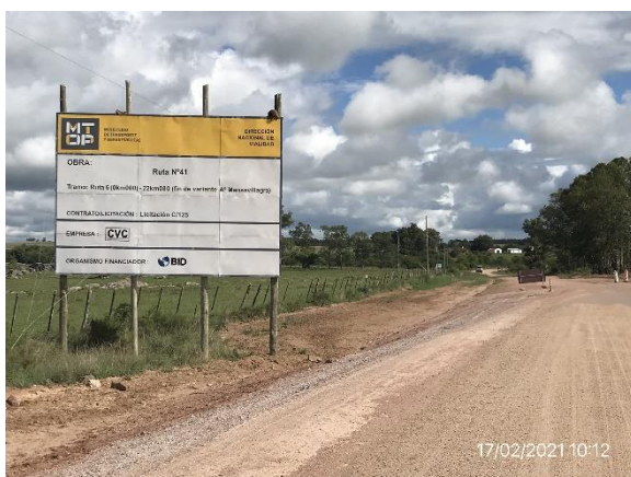
Ilustración 8 – P02, Fin de tramo, Ruta 41 progresiva 22K800.
