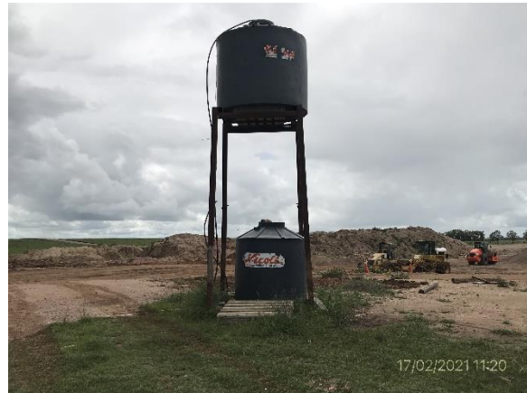
Ilustración 11 – P03, Obrador. Tanque de agua.
