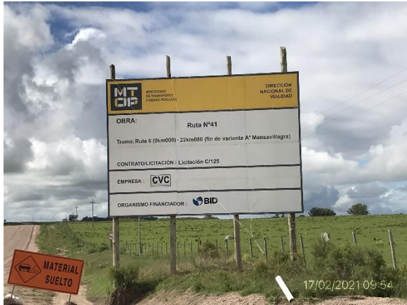
Ilustración 4 – P01, Inicio de tramo, Ruta 41 progresiva 0K000, empalme con Ruta 6.
