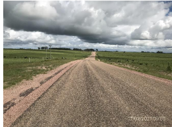
Ilustración 5 – P01, Obras terminadas en Ruta 41. Inicio de tramo.
