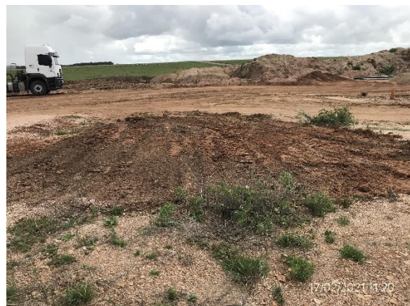
Ilustración 15 – P03, Obrador. Depósito impermeable para baños relleno con terreno circundante nivelado.
