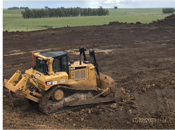
Ilustración 17 – P03, Cantera. Trabajos de remediación ambiental en proceso con suavizado de taludes.
