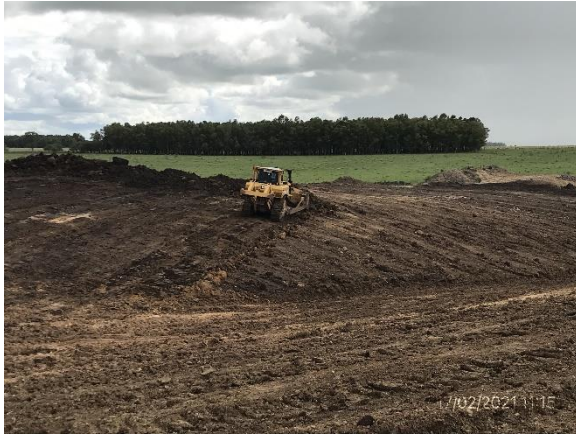
Ilustración 16 – P03, Cantera. Trabajos de remediación ambiental en proceso con suavizado de taludes.
