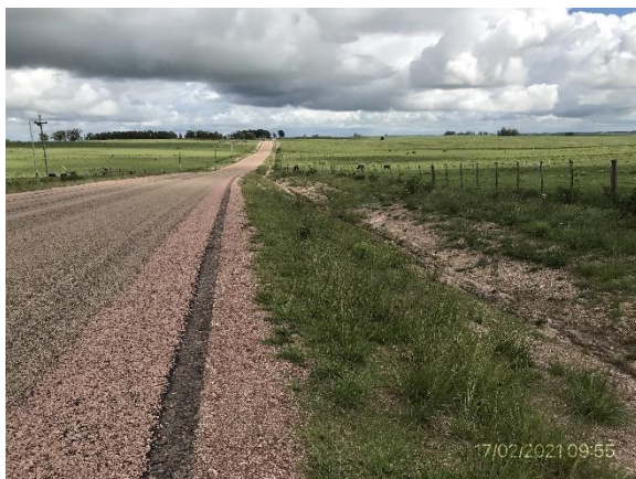
Ilustración 6 – Obras terminadas en Ruta 41, Cunetas limpias con empastado en crecimiento
