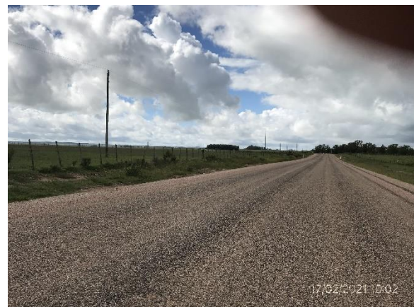
Ilustración 7 – Obras terminadas en Ruta 41
