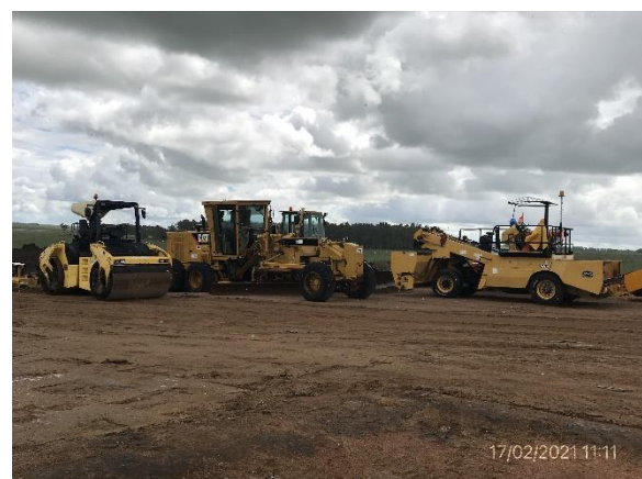
Ilustración 9 – P03, Obrador. Estacionamiento de maquinaria detenida, a ser trasladada próximamente.
