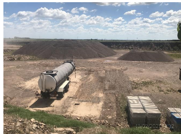
Ilustración 21 – P03, Cantera. Sector de acopio de áridos triturados.
