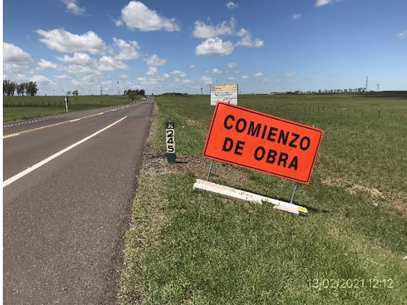
Ilustración 4 – P01, Ruta 5 progresiva 245K000. Fin de tramo.
