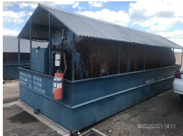
Ilustración 13 – P03. Obrador. Depósito de Gas Oil techado con envallado perimetral.
