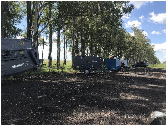
Ilustración 10 – P04, Campamento Provisionario. Ruta 5 progresiva 272K000 a (-). No hay infraestructura para gestión de residuos.
