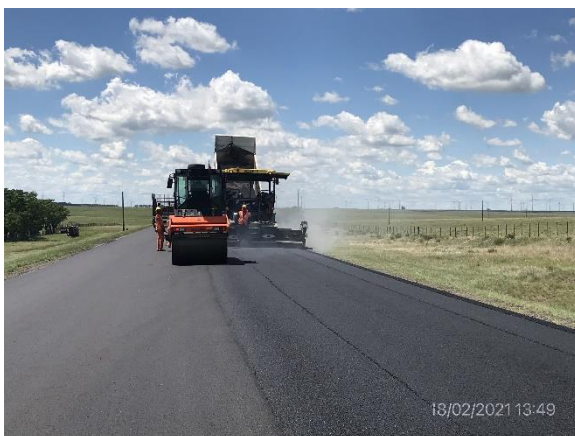
Ilustración 8 – P05, Frente de obra. Ruta 5, tramo progresiva 269K000.
