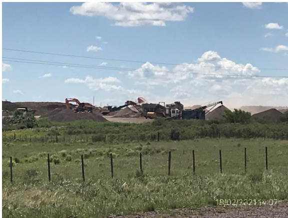
Ilustración 12 – P03, Obrador, cantera y planta asfáltica. Ruta 5 progresiva 292K500 a (-). Vista general.
