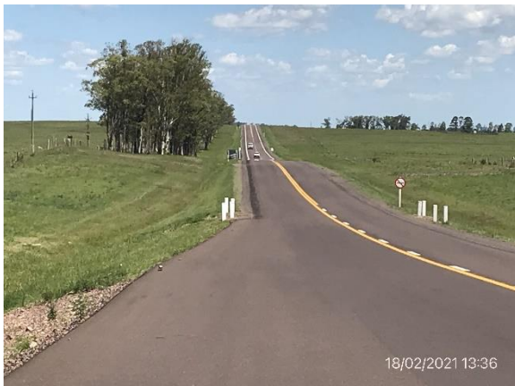
Ilustración 6 – Ruta 5, inicio de tramo de tercera vía de sobrepaso terminada.
