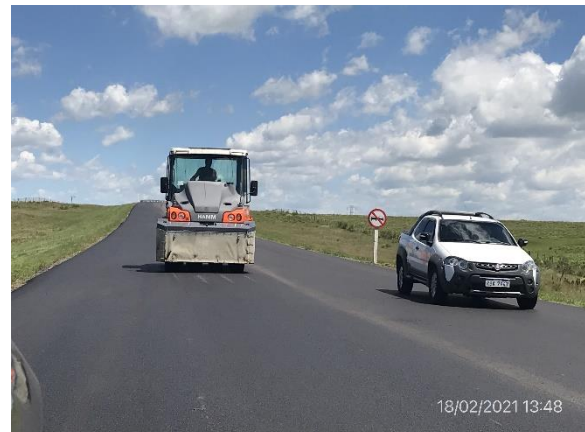
Ilustración 7 – P05. Ruta 5, frente de obra, tramo progresiva 269K000 a (-).
