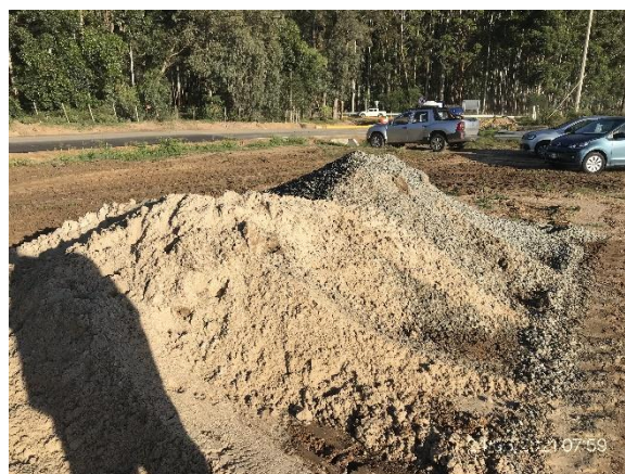
Ilustración 13 – P02. Campamento provisorio. Acopio de agregados.
