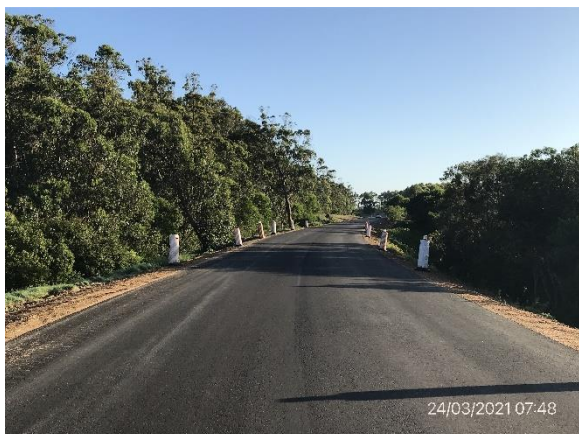
Ilustración 8 – Tramo de obras culminado, desvío de tránsito pesado al puerto de La Paloma.
