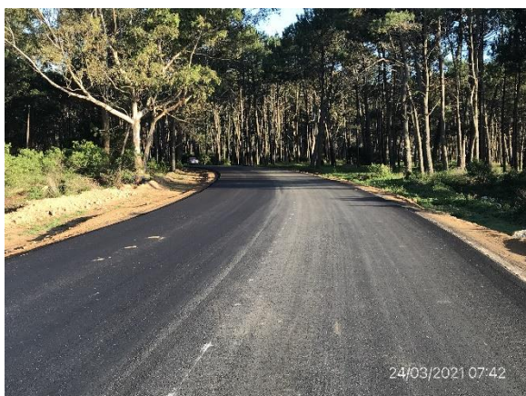
Ilustración 6 – Tramo de obras culminado, desvío de tránsito pesado al puerto de La Paloma.
