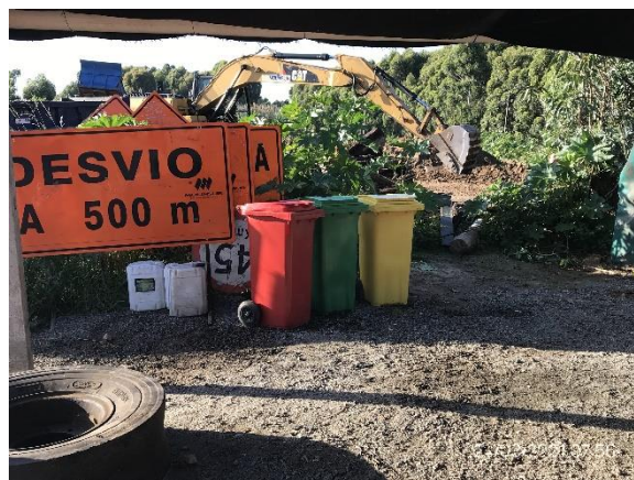
Ilustración 11 – P02. Campamento provisorio. Estación de segregación de residuos según origen.
