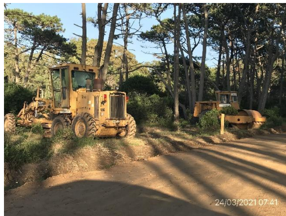
Ilustración 5 – P01, Inicio de tramo de obras, desvío de tránsito pesado al puerto de La Paloma. Nueva rotonda en construcción. Estacionamiento de maquinaria en faja pública.
