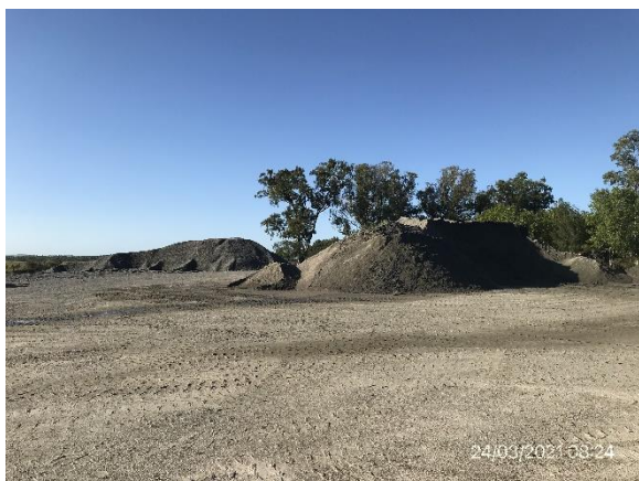
Ilustración 16 – P03, Obrador. Acopio de áridos.
