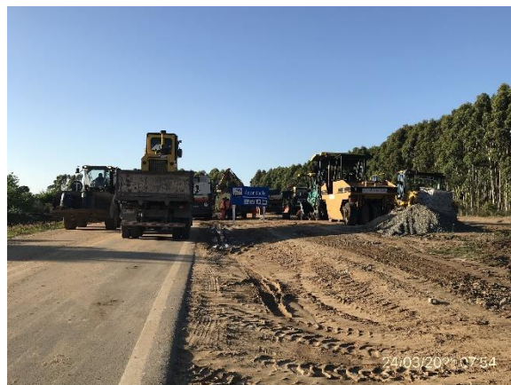
Ilustración 9 – P02, Fin de tramo de obras, desvío de tránsito pesado al puerto de La Paloma. Nueva rotonda en construcción.
