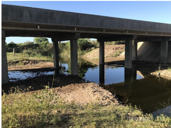
Ilustración 10 – P03, Obra terminada en puente sobre A° Guayabo Chico (82K730), ataguías desmontadas.
