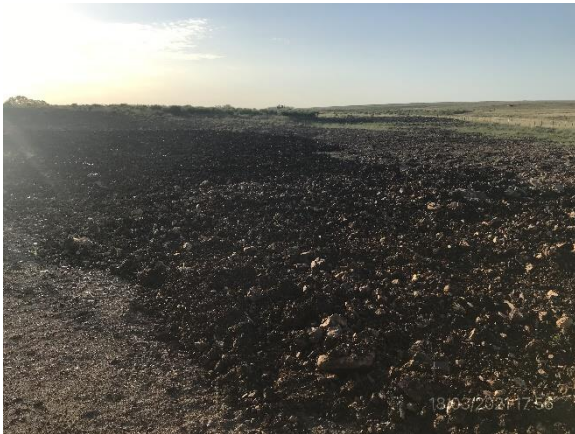
Ilustración 24 – P07, Cantera de basalto. Tendido de taludes y relleno de zona explotada en ejecución.
