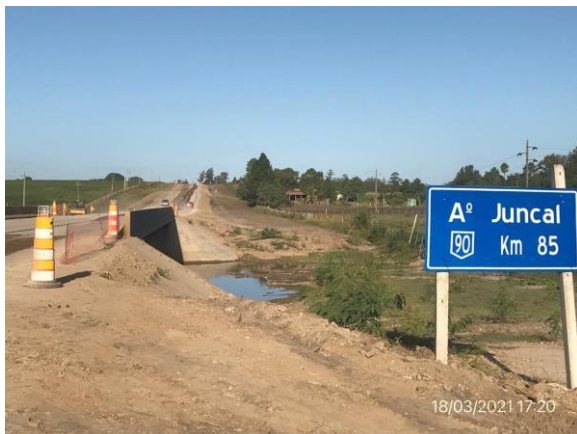
Ilustración 12 – P04, Obra terminada en puente sobre A° Juncal (85K110), losa superior.
