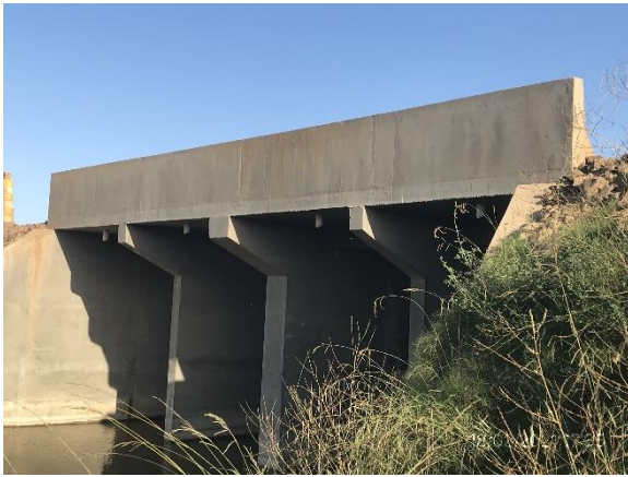
Ilustración 16 – P05, Obra terminada en puente sobre C da del Sauce (87K810), ataguías desmontadas.
