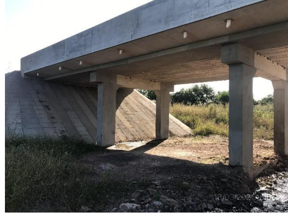
Ilustración 5 – P01, Obra terminada en puente sobre A° Caraguatá (76K750), vista inferior.
