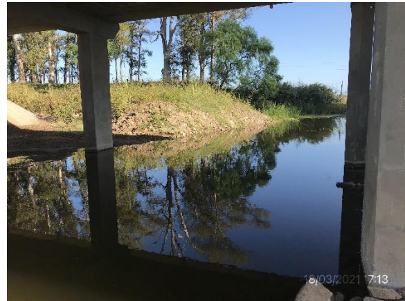
Ilustración 11 – P03, Obra terminada en puente sobre A° Guayabo Chico (82K730), vista del cauce con correcta recuperación ambiental.
