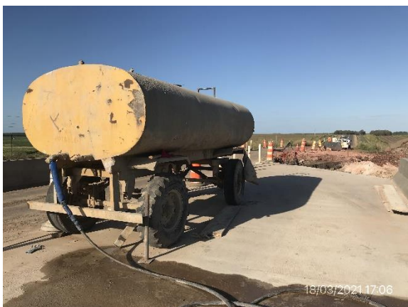
Ilustración 8 – P02, Obra en ejecución en puente sobre vía férrea (76K750).
