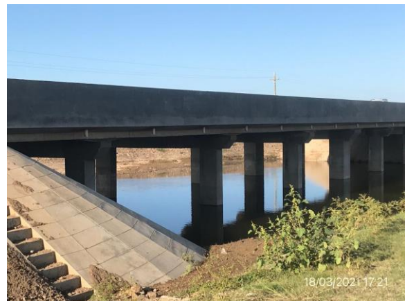
Ilustración 13 – P04, Obra terminada en puente sobre A° Juncal (85K110), ataguías desmontadas
