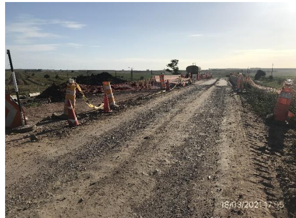
Ilustración 7 – P02, Obra en ejecución en puente sobre vía férrea (76K750).
