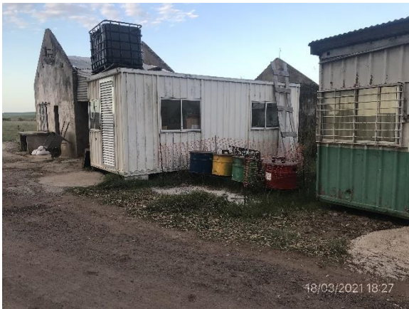
Ilustración 18 – P06, Obrador. Estación de residuos segregados por canal.
