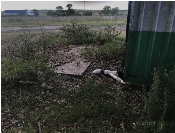
Ilustración 22 – P06, Obrador. Depósito impermeable en zona de baños.
