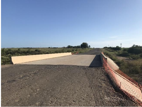
Ilustración 4 – P01, Obra terminada en puente sobre A° Caraguatá (76K750), losa superior.
