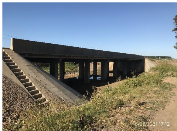
Ilustración 9 – P03, Obra terminada en puente sobre A° Guayabo Chico (82K730), vista inferior.
