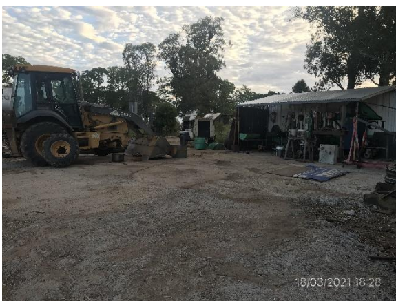
Ilustración 20 – P06, Obrador. Taller mecánico con pavimento impermeable.
