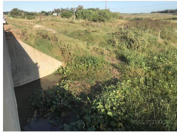
Ilustración 17 – P05, Obra terminada en puente sobre C da del Sauce (87K810), vista del cauce con correcta recuperación ambiental
