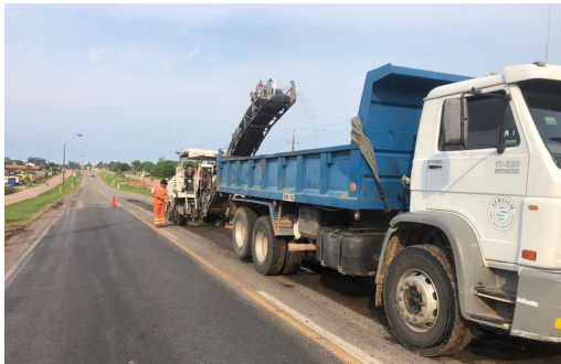
bacheo en calzada
