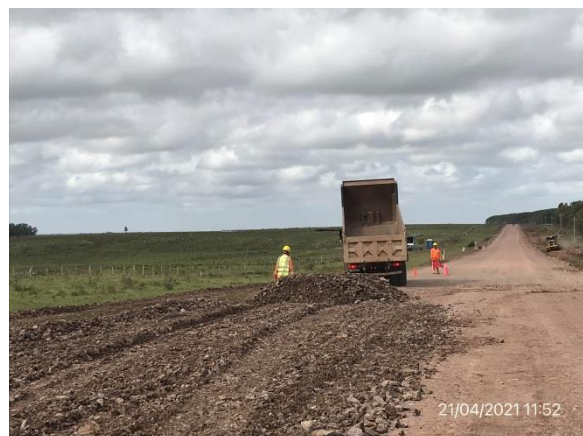
Ilustración 9 – Frente de obra, Ruta 43 progresiva 34K500.
