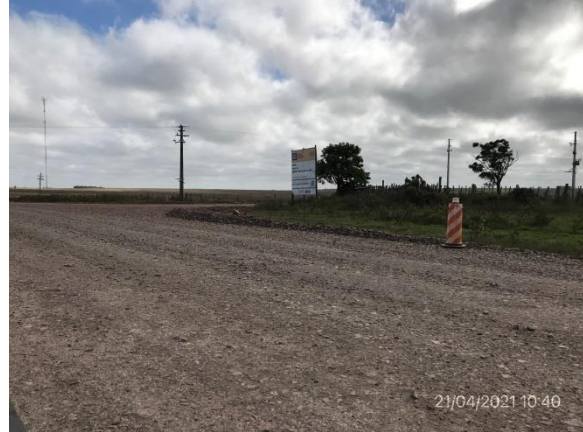
Ilustración 5 – P01, Ruta 43 progresiva 28K600, inicio de tramo.
