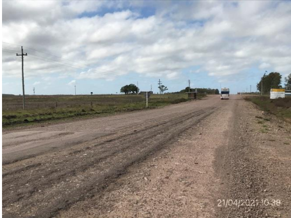
Ilustración 4 – P01, Ruta 43 progresiva 28K600, inicio de tramo.
