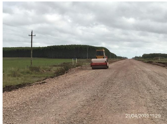
Ilustración 7 – Frente de obra, Ruta 43 progresiva 34K500.
