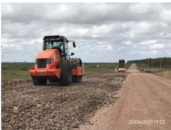
Ilustración 8 – Frente de obra, Ruta 43 progresiva 34K500.
