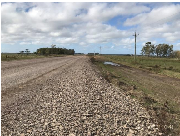
Ilustración 6 – Ruta 43, Trabajos de conformación de base, cuneta y drenajes en ejecución.
