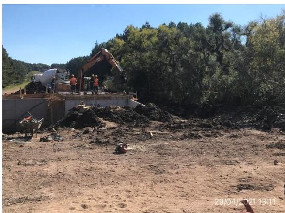
Ilustración 6 – P06, Alcantarilla en construcción. Explanada de acceso. Subcontrato Suelo Firme SRL
