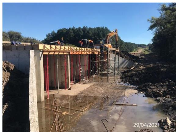
Ilustración 7 – P06, Alcantarilla en construcción. Tablero superior en construcción. Subcontrato Suelo Firme SRL
