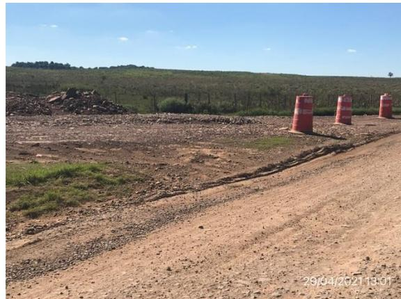
Ilustración 5 – Cno. Los Cuadros. Trabajos de ensanche de base.
