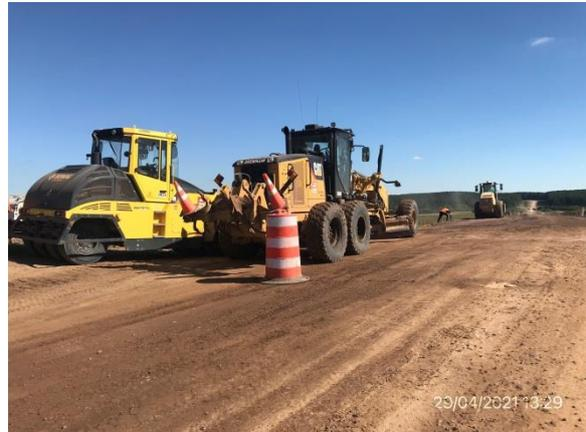
Ilustración 17 – Frente de obra. Trabajos de ensanche y recargo de base.
