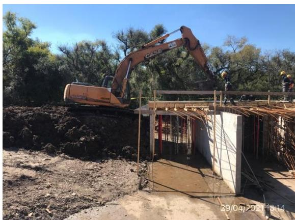
Ilustración 8 – P06, Alcantarilla en construcción. Subcontrato Suelo Firme SRL.
