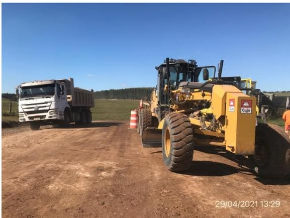
Ilustración 18 – Frente de obra. Trabajos de ensanche y recargo de base.
