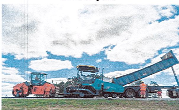
colocación de mezcla
