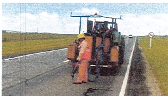
selladora de grietas
