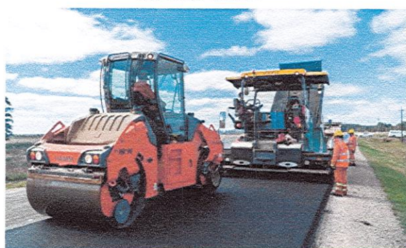
Compactación de mezcla
