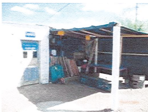
vista exterior de la sede de Mariscal
