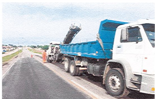
bacheo en calzada
