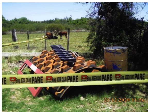
Ilustración 7 – P04, obrador secundario. Repuestos de maquinaria correctamente acopiados.
