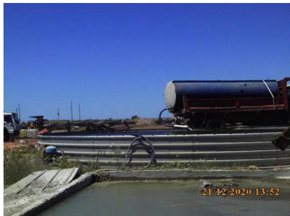
Ilustración 16 – P03, obrador principal. Vaciado de camión cisterna con agua de arroyo en tanque australiano para su uso elaboración de nuevo hormigón.
