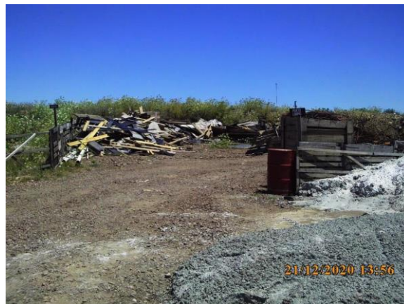
Ilustración 17 – P03, obrador principal. Zona de residuos clasificados y acopiados temporalmente previo a su disposición final.
