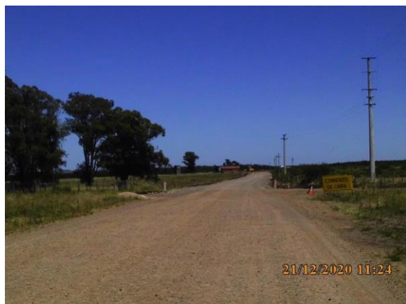
Ilustración 4 – P01, Inicio de tramo de obras.
