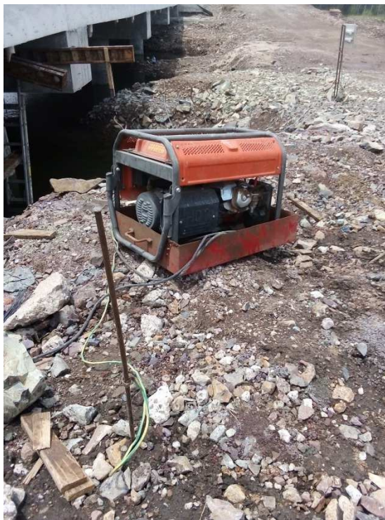
Imagen tomada el 12/01/2021 en el frente de Obra de construcción del puente sobre Arroyo El Tala.
