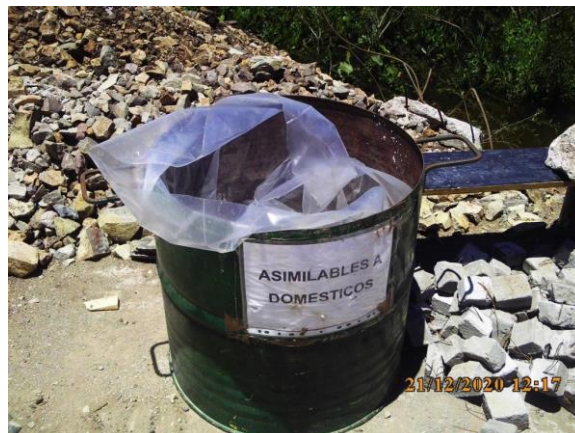
Ilustración 11 – Correcta clasificación de residuos en zona de frente de obra.
