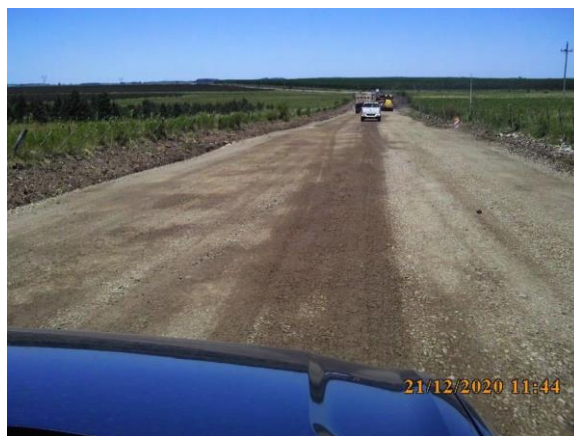
Ilustración 5 – Caminos de obra luego de regado para reducir la presencia de polvo en el aire.
