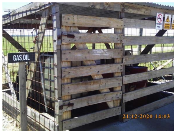
Ilustración 19 – P03, obrador principal. Depósito de lubricantes.
