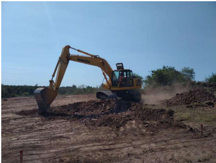
Ilustración 25 Obras de excavación en Sector 2.
