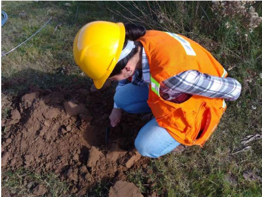
Ilustración 15 Inspección de Sondeo 2.
