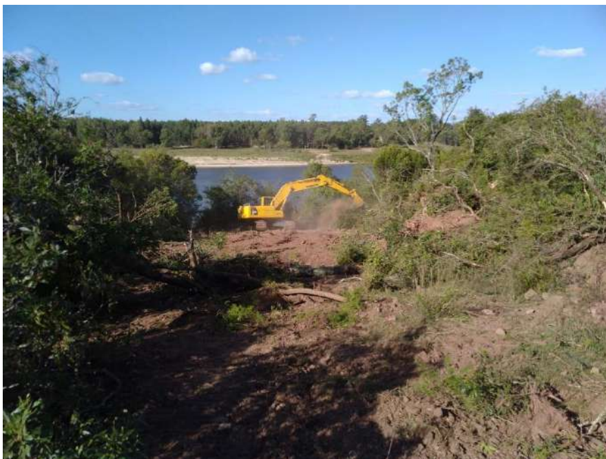
Ilustración 17 Avance de la remoción de cobertura vegetal.
