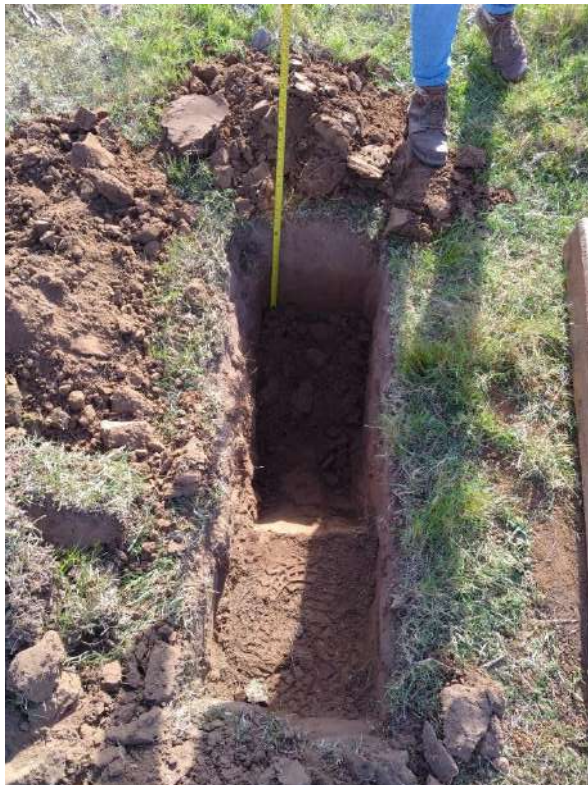
Ilustración 13 Excavación de Sondeo 2.
