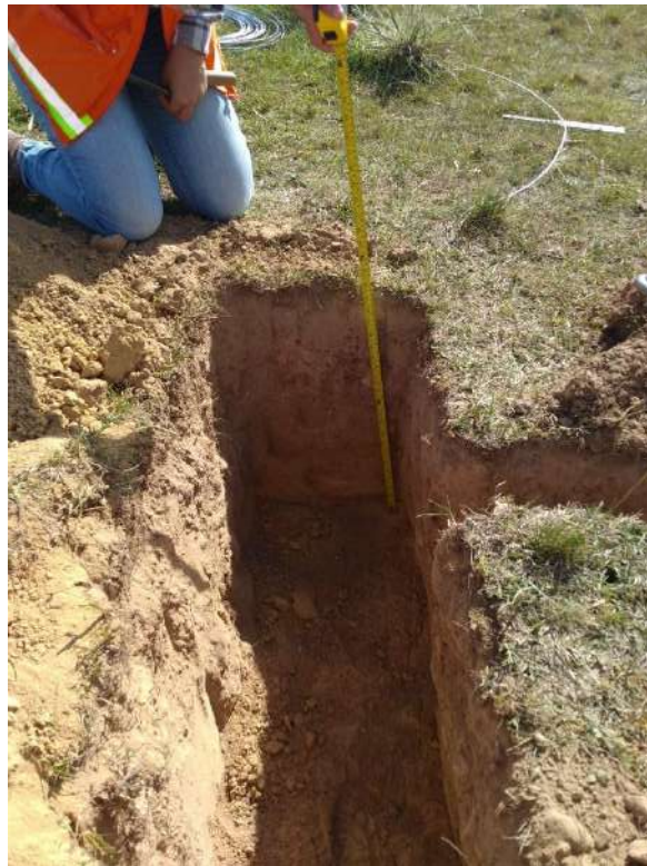
Ilustración 10 Sondeo para "muertos" de poste.
