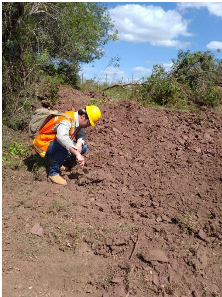
Ilustración 19 Inspección de escombrera de remoción de cobertura vegetal.
