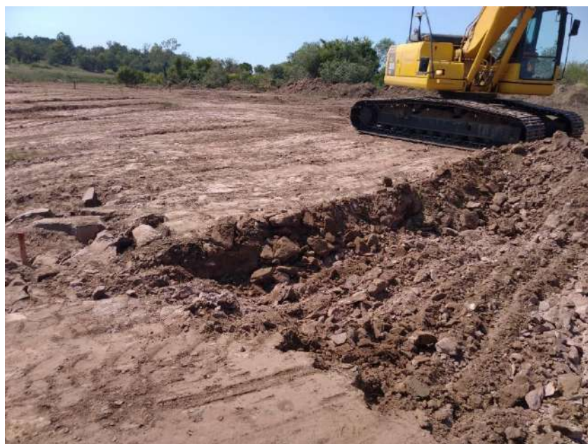
Ilustración 26 Material removido en Sector 2.
