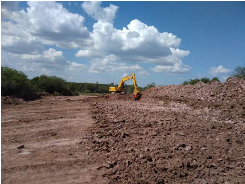
Ilustración 28 Avance de las obras en el Sector 2.
