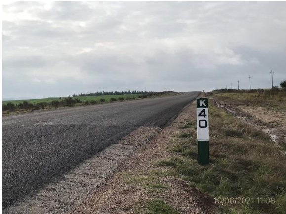
Ilustración 4 – P01, inicio de tramo. Ruta 56 progresiva 40K000.
