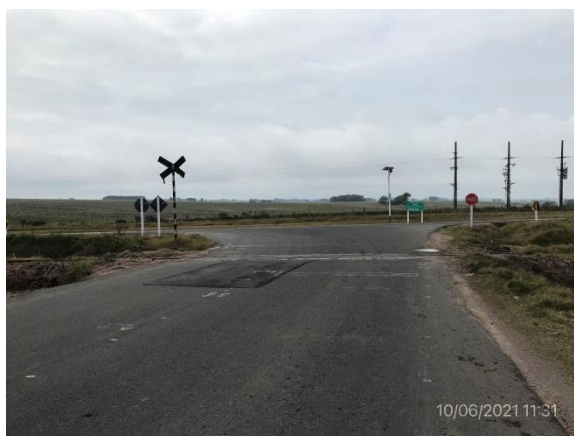
Ilustración 9 – P02, Fin de tramo, 56 progresiva 56K000, empalme con Ruta 7.
