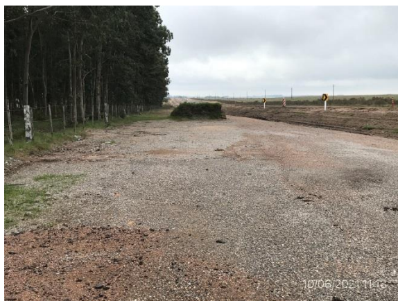
Ilustración 7 – P03, Obrador desmantelado con recuperación ambiental realizada. Acopio de áridos remanente a disposición de DNV – MTOP.
