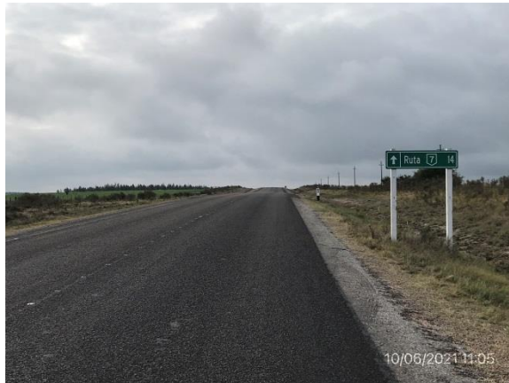
Ilustración 5 – P01, inicio de tramo. Ruta 56 progresiva 40K000.
