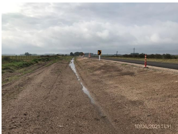
Ilustración 6 – Tramo de ruta terminado, drenajes adecuadamente perfilados con empastado incipiente.
