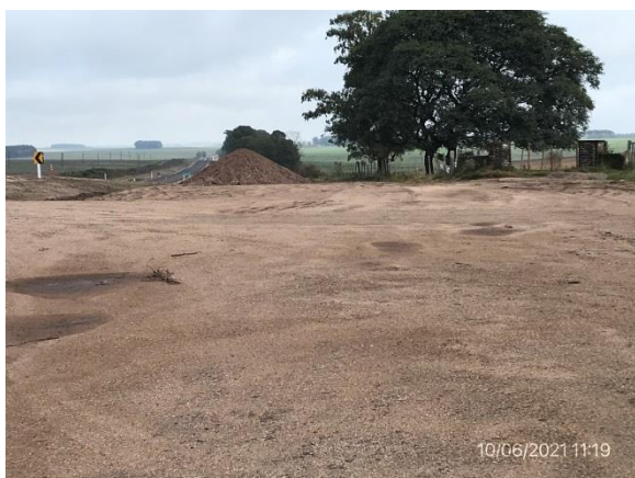
Ilustración 8 – P03, Obrador desmantelado con recuperación ambiental realizada. Acopio de áridos remanente a disposición de DNV – MTOP.
