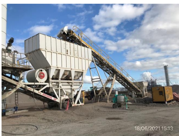
Ilustración 14 – P03. Obrador principal. Planta de hormigón, silos de áridos en proceso de carga.
