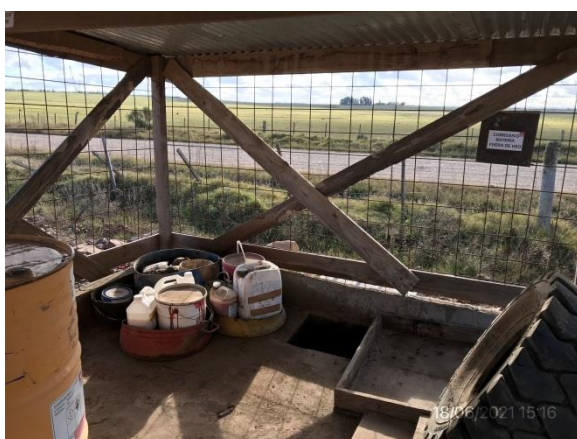
Ilustración 20 – P03. Obrero principal. Depósito de lubricantes techado con bandejas metálicas y envallado perimetral.
