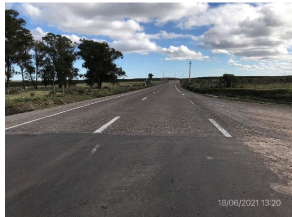
Ilustración 11 – P02. Fin de tramo de obras. Camino El Tala, progresiva 15K600.
