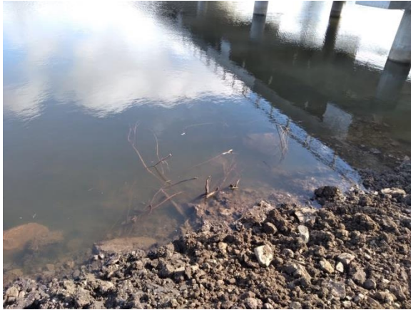
Ilustración 22 – P04. Puente terminado sobre ramal principal de A° Tala. Fueron removidos los escombros del lecho del cauce. Foto proporcionada por la empresa el 21/07/2021.
