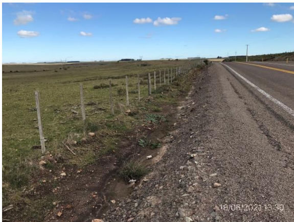
Ilustración 6 – Obras terminadas en el Cno. El Tala. Drenajes construidos y taludes con empastado incipiente
