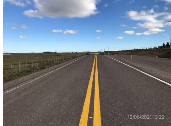
Ilustración 5 – Obras terminadas en el Cno. El Tala, capa de rodadura en tratamiento bituminoso y señalización horizontal y vertical terminadas.
