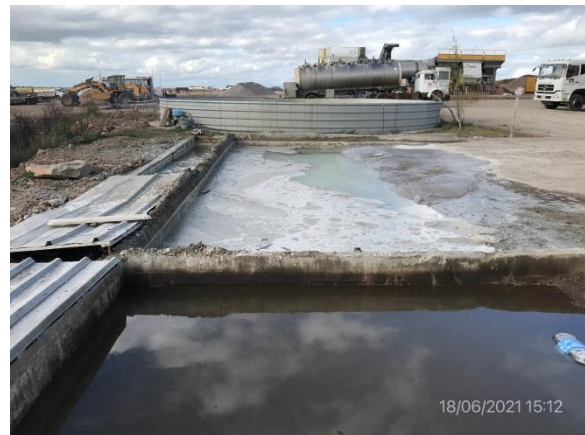
Ilustración 17 – P03. Obrero principal. Planta de lavado de camiones mixer con circuito cerrado de recirculación de aguas.
