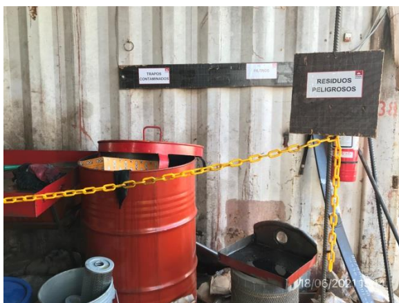
Ilustración 18 – P03. Obrero principal. Depósitos de residuos segregados por corriente de generación.
