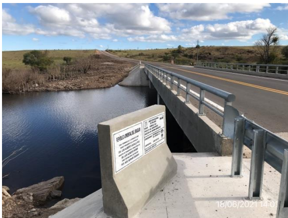
Ilustración 8 – P04. Puente terminado sobre ramal principal de A° Tala, Cno. El Tala progresiva 10K600.
