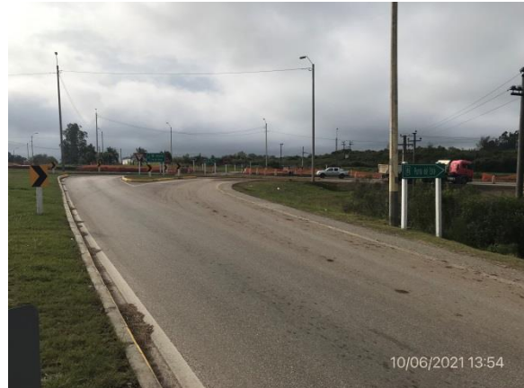
Ilustración 5 – P01, Inicio de tramo de obras de Ruta 37 en intersección con Ruta Interbalnearia.
