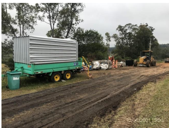
Ilustración 8 – P03, campamento provisorio Ruta 37 progresiva 5K900. Zona de acopio de materiales e insumos, estacionamiento de equipos y maquinaria.
