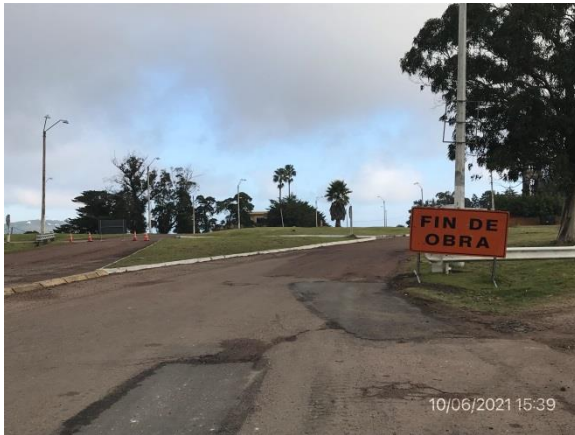
Ilustración 10 – P02, Fin de tramo de obras de Ruta 37, progresiva 8K300.
