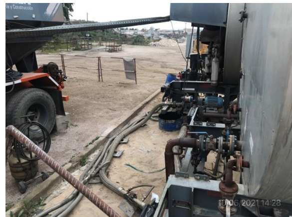
Ilustración 13 – P04, Planta asfáltica con envallado perimetral adecuado.
