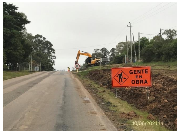
Ilustración 7 – Ruta 37, trabajos de excavación en ejecución.
