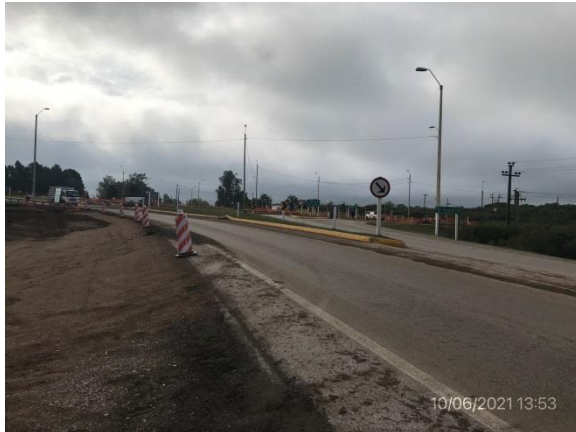
Ilustración 4 – P01, Inicio de tramo de obras de Ruta 37 en intersección con Ruta Interbalnearia.
