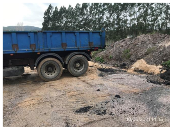
Ilustración 21 – P04, Planta asfáltica. Sector destinado por la empresa para lavado de camiones que transportan asfalto. No cuenta con superficie impermeable ni sistema de intercepción de hidrocarburos
