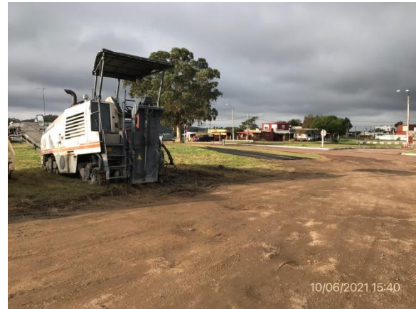
Ilustración 11 – P02, Fin de tramo de obras de Ruta 37, progresiva 8K300. Estacionamiento de maquinaria.
