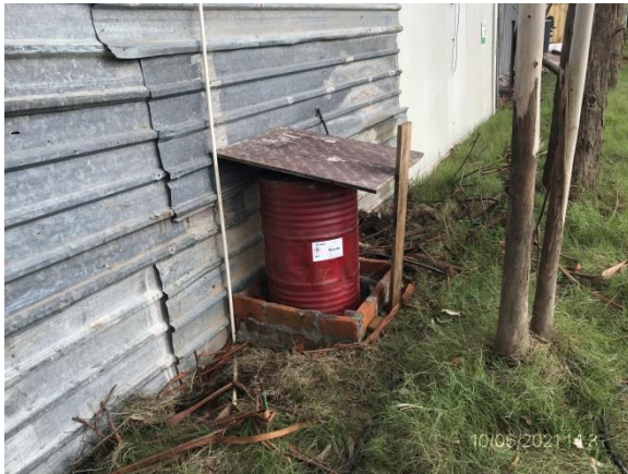
Ilustración 16 – P04, Obrador, laboratorio de asfaltos. Depósito de percloroetileno estanco, techado y envallado.
