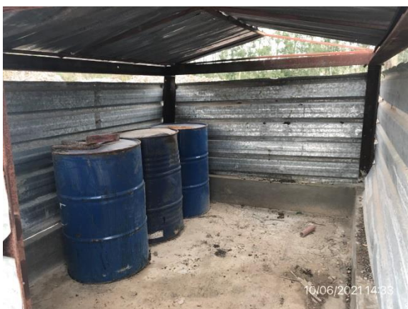
Ilustración 20 – P04, Obrador. Depósito estanco para acopio de lubricantes.
