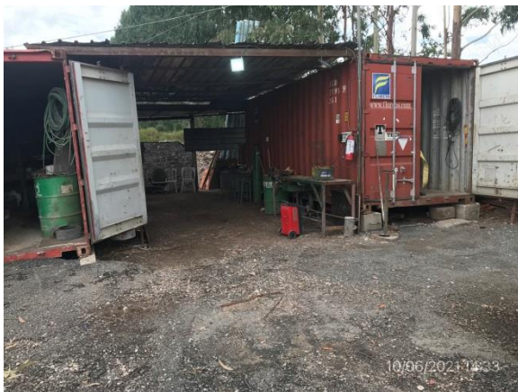
Ilustración 18 – P04, Obrador. Taller mecánico techado y con pavimento impermeable
