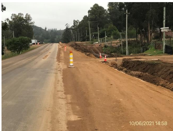
Ilustración 6 – Ruta 37, trabajos de ensanche de base en ejecución.
