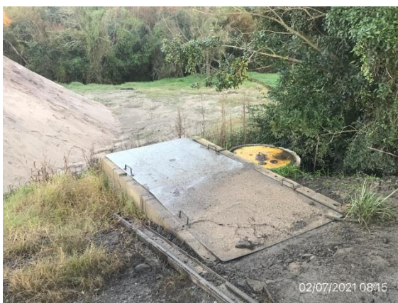
Ilustración 7 – P03 Obrador. pileta de decantación de hidrocarburos
