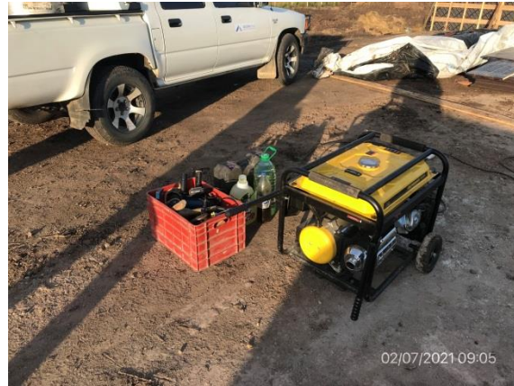
Ilustración 17 – P06, frente de obras. Obrador secundario sin infraestructura para gestión de residuos, hidrocarburos ni bandejas de contención. Subcontratista Golden Sand SRL.
