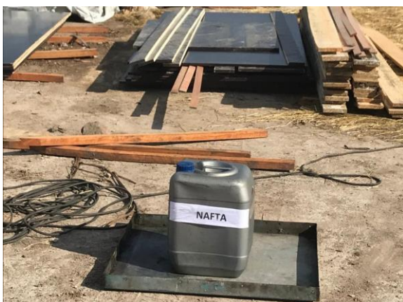
Ilustración 20 – P06, frente de obras. Alcantarilla en construcción. Subcontratista Golden Sand SRL. Nueva infraestructura para acopio de combustibles. Foto proporcionada por la empresa 04/07/2021.
