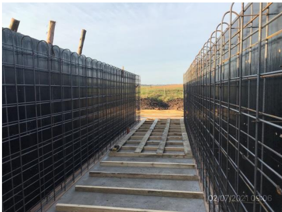
Ilustración 18 – P06, frente de obras, alcantarilla en construcción. Subcontratista Golden Sand SRL
