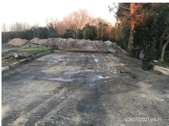
Ilustración 6 - P03 - Obrador. Zona de lavado de camiones con cordoneta perimetral y pendientes hacia pileta de decantación de hidrocarburos
