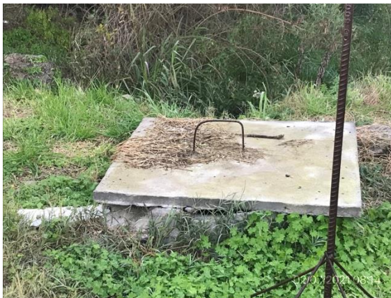
Ilustración 5 - P03 - Obrador. Depósito impermeable para contención de efluentes domésticos
