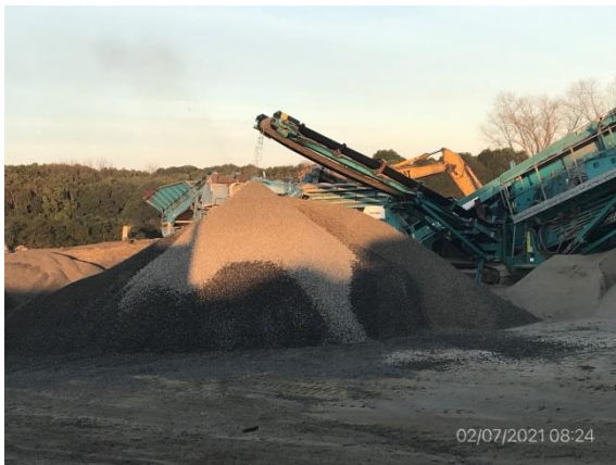
Ilustración 12 – P03, Obrador. Zona de trituración secundaria
