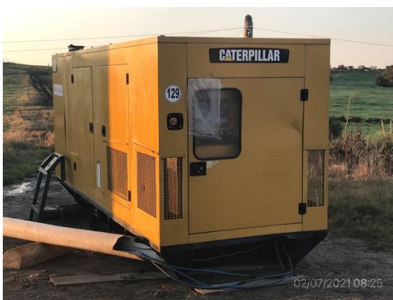
Ilustración 9 – P03, Obrador. Grupo electrógeno de respaldo, sin contención impermeable en piso y perímetro.
