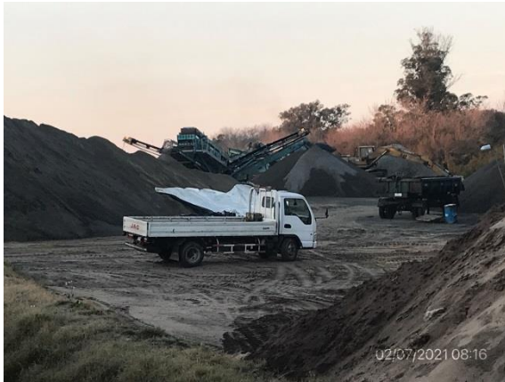
Ilustración 10 – P03, Obrador. Zona de acopios de áridos
