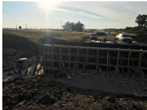
Ilustración 19 – P06, frente de obras. Alcantarilla en construcción. Subcontratista Golden Sand SRL
