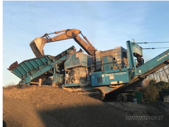
Ilustración 11 – P03, Obrador. Zona de trituración secundaria.
