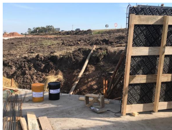
Ilustración 21 – P06, frente de obras. Alcantarilla en construcción. Subcontratista Golden Sand SRL. Nueva infraestructura para gestión de residuos. Foto proporcionada por la empresa 04/07/2021.
