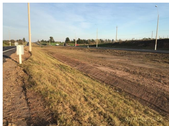
Ilustración 15 – Ruta 1. Obras obligatorias culminadas. Recuperación ambiental del tramo ejecutada, empastado correcto y drenajes adecuados.
