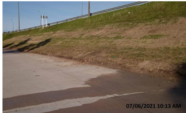
Ilustración 5 – P03, Obrador provisorio. Tareas de PRA ejecutadas.
