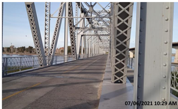
Ilustración 6 – Obras de arenado y pintura en puente metálico sobre Puente Santa Lucía
