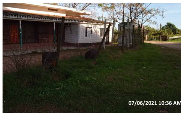
Ilustración 9 – P04, Obrador MTOP. Tareas de PRA ejecutadas.
