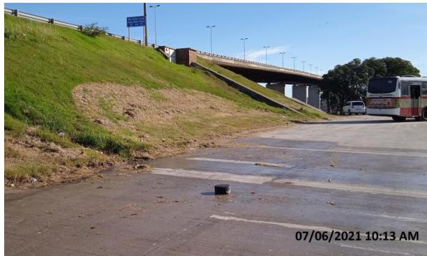
Ilustración 4 – P03, Obrador provisorio. Tareas de PRA ejecutadas.
