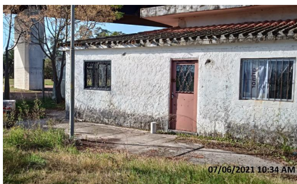
Ilustración 8 – P04, Obrador MTOP. Tareas de PRA ejecutadas.
