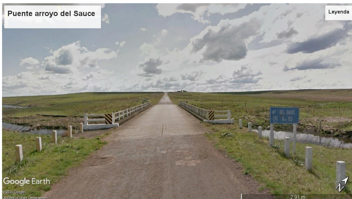
Ilustración 2-3 Situación actual puente arroyo del Sauce
