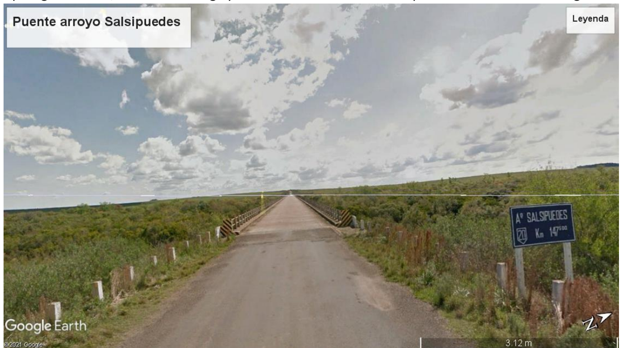
Ilustración 2-5 Situación actual puente arroyo Salsipuedes
