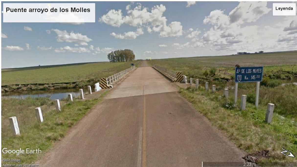
Ilustración 2-1 Situación actual Puente arroyo de los Molles
