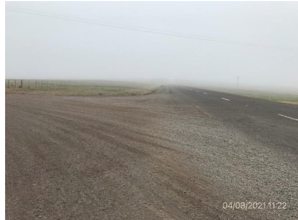
Ilustración 5 – P01, Inicio del tramo. Ruta 4, progresiva 256K700, intersección con Cno. El Tala.
