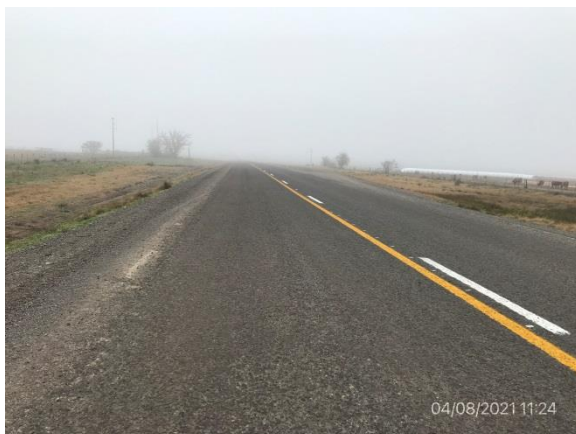
Ilustración 6 – Ruta 4, Tramo construido.
