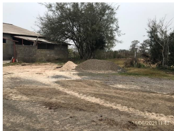
Ilustración 11 – P03, Obrador. Ruta 4, progresiva 270K500 a (-). Acopios de áridos.
