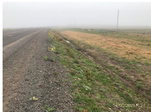
Ilustración 7 – Ruta 4, Drenajes adecuados con empastado incipiente en nuevas cunetas.
