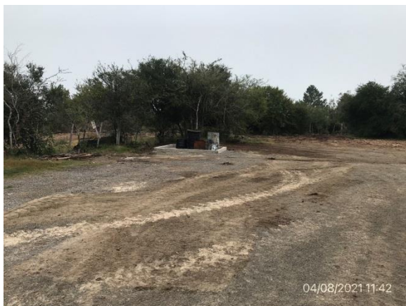
Ilustración 12 – P03, Obrador. Ruta 4, progresiva 270K500 a (-). Explanada de maniobras nivelada.
