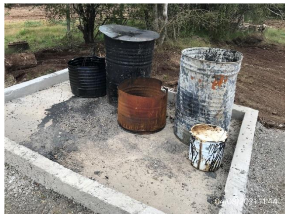
Ilustración 13 – P03, Obrador. Ruta 4, progresiva 270K500 a (-). Recinto envallado con pavimento impermeable para alojar emulsiones asfálticas.
