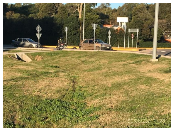
Ilustración 9 – P03, Tareas de recuperación ambiental ejecutadas, drenajes y cobertura vegetal adecuados en nueva rotonda de acceso a Playa Pascual.
