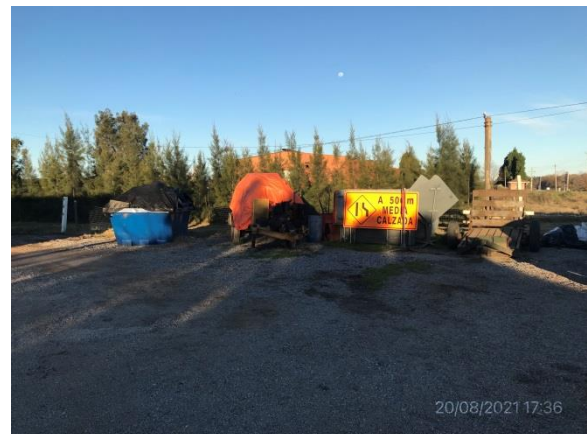
Ilustración 13 – P05 – Obrador de subcontratista Monerden SA. Ruta 1 progresiva 37K900 a (+) Equipamiento menor Traxpalco SA.
