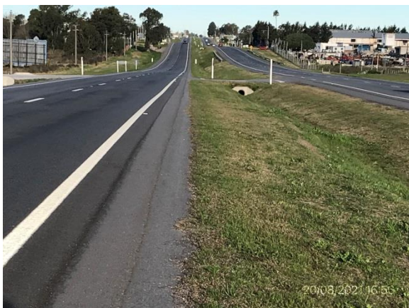
Ilustración 6 – Obras obligatorias de mantenimiento culminadas en Ruta 1, recapado en carpeta asfáltica.
