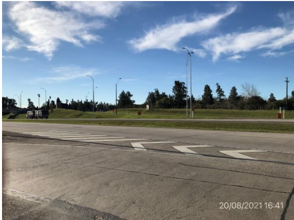
Ilustración 4 – P02, Fin de tramo. Ruta 1 progresiva 67K600, empalme con Ruta 3.
