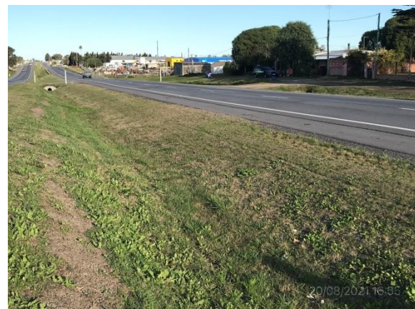
Ilustración 7 – Tareas de recuperación ambiental ejecutadas, drenajes y cobertura vegetal adecuados.
