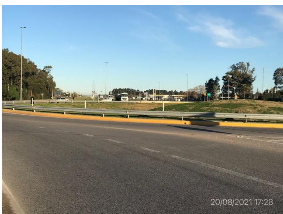
Ilustración 8 – P03, Obras terminadas para nueva rotonda de acceso a Playa Pascual.
