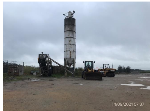
Ilustración 7 – P04. Obrador principal. Planta de hormigón sin uso.
