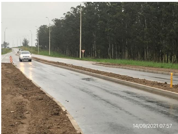
Ilustración 6 – P01, Empalme con acceso a relleno sanitario Intendencia de Rocha. No hay tapiz vegetal sobre material inerte de relleno de cantera.
