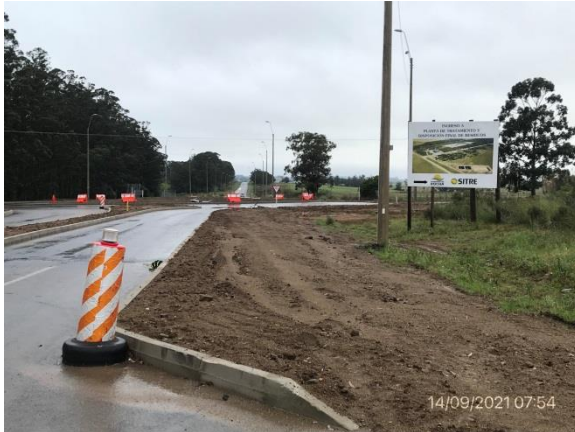
Ilustración 4 – P01, Empalme con acceso a relleno sanitario Intendencia de Rocha.
