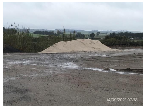
Ilustración 9 – P04, Obrador principal.
