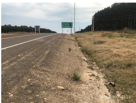
Ilustración 8 – Ruta 90, Obras terminadas. Drenajes adecuados y faja pública con tareas de remediación ambiental ejecutadas.
