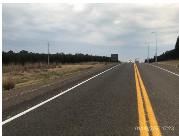
Ilustración 7 – Ruta 90, Obras terminadas.
