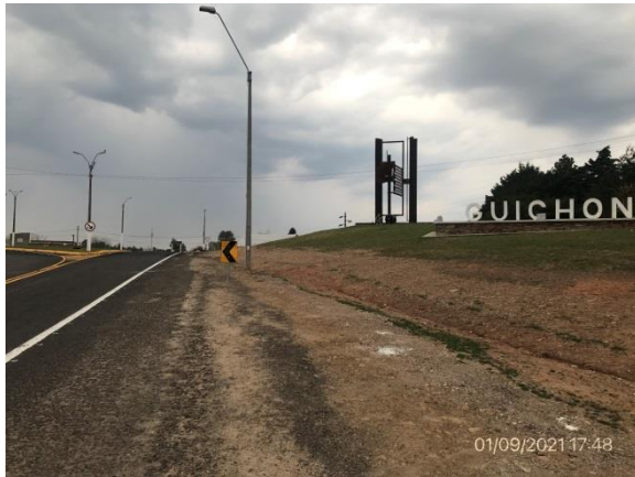
Ilustración 10 – P02, Fin de tramo de obras. Acceso a ciudad de Guichón.
