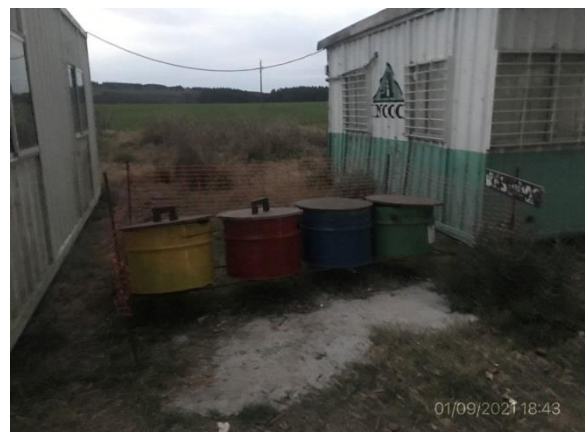
Ilustración 15 – P08, Obrador. Estación de residuos segregados por canal.
