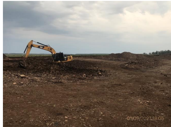
Ilustración 17 – P09, Cantera de basalto. Tendido de taludes y relleno de zona explotada en ejecución.
