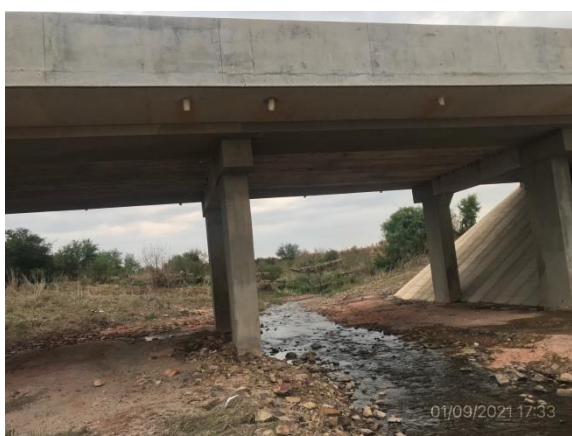
Ilustración 9 – P03, Puente sobre Aº Caraguatá, Ruta 90 progresiva 76K750. Remoción de ataguía culminada
