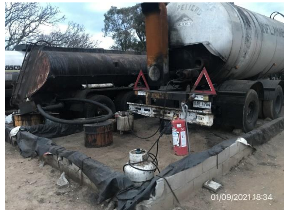
Ilustración 13 – P08, Obrador. Acopio de emulsiones asfálticas con envallado perimetral perforado.
