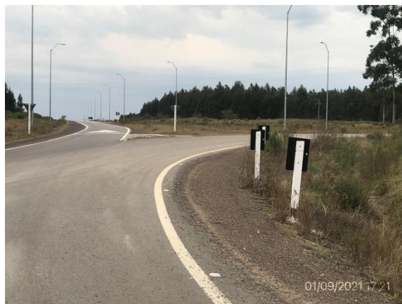
Ilustración 5 – P01, Empalme de Ruta 90 y Ruta 25, inicio de tramo de obras en Ruta 90.
