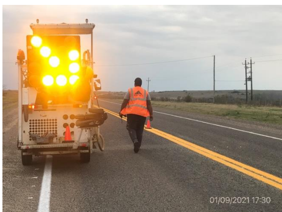
Ilustración 6 – Ruta 90, Trabajos de ejecución de señalización horizontal.
