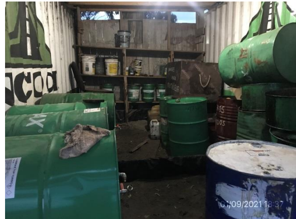
Ilustración 11 – P08, Obrador. Acopio de lubricantes usados techado y envallado con pavimento impermeable.
