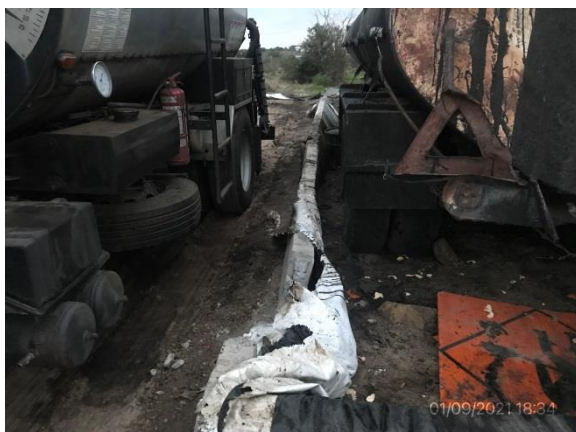
Ilustración 14 – P08, Obrador. Envallado perimetral de depósito de emulsiones asfálticas impermeabilización dañada.
