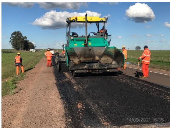
Ilustración 12 – Ruta 43. Trabajos de bacheo por mantenimiento en garantía.
