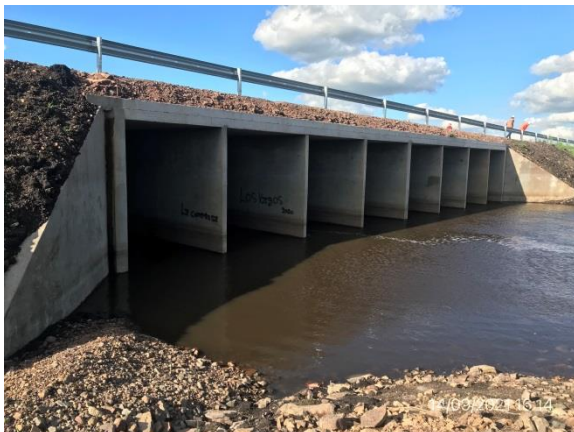
Ilustración 8 – P04. Puente sobre Arroyo Cardozo. Ruta 43, 7K130. Terraplenes retirados.
