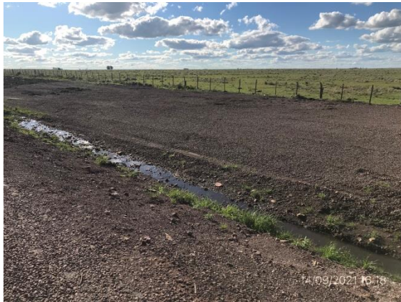
Ilustración 10 – P04. Puente sobre Arroyo Cardozo. Ruta 43, 7K130. Obrador subcontratista SACEEM desmontado y con remedación ambiental realizada.
