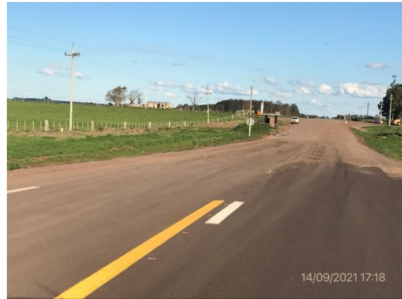
Ilustración 11 – P02, Fin de tramo de obras. Ruta 43, progresiva 28K600, empalme con Ruta 59.
