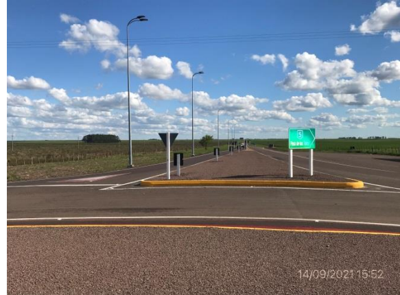
Ilustración 5 – P01, Inicio de tramo de obras. Rotonda de empalme de Ruta 43 y Ruta 5.
