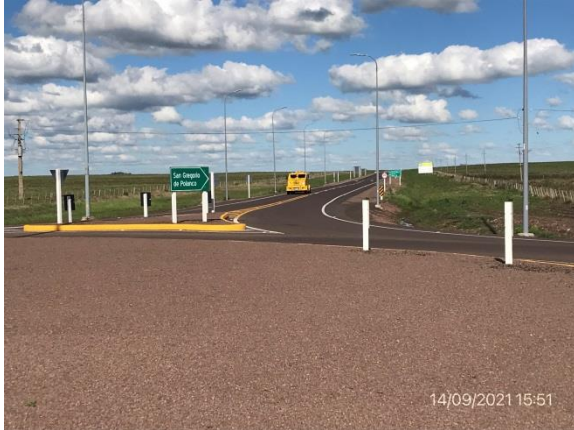
Ilustración 4 – P01, Inicio de tramo de obras. Rotonda de empalme de Ruta 43 y Ruta 5.
