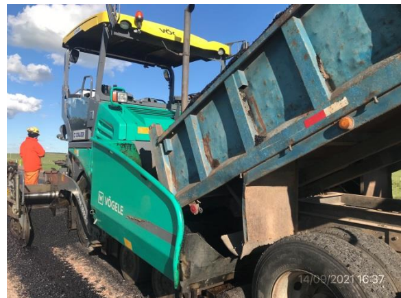
Ilustración 13 – Ruta 43. Trabajos de bacheo por mantenimiento en garantía.
