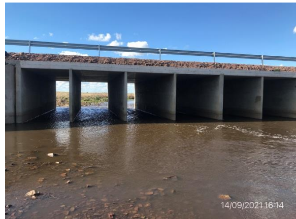
Ilustración 9 – P04. Puente sobre Arroyo Cardozo. Ruta 43, 7K130. Cauce limpio.
