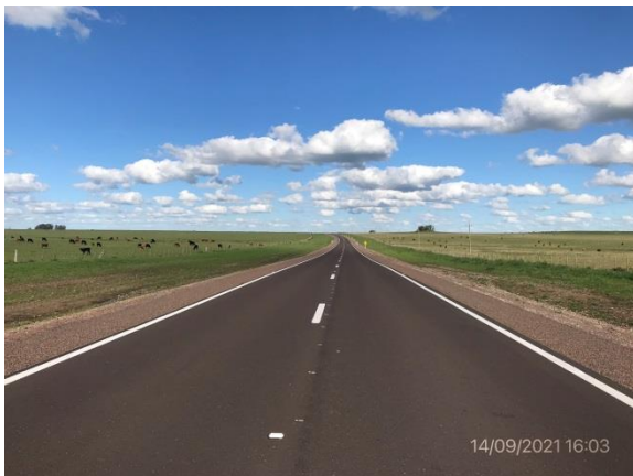
Ilustración 6 – Ruta 43. Trabajos de adecuación y señalización terminados.
