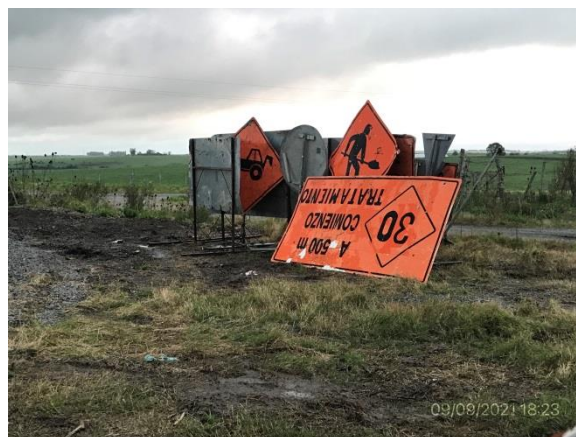
Ilustración 13 – P13, Campamento pvisorio, Ruta 77 progresiva 19K700 a (+).
