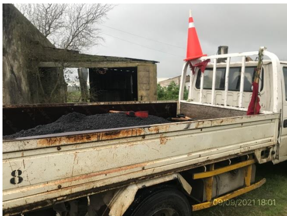
Ilustración 10 – Frente de obras. Bacheo en ejecución, Ruta 12 progresiva 23K300.
