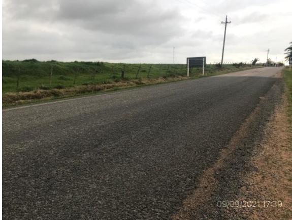
Ilustración 4 – Obras obligatorias de bacheo terminadas en Ruta 76.
