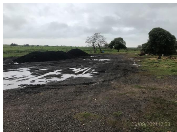
Ilustración 9 – P13, Campamento pavoroso, Ruta 77 progresiva 19K700 a (+). Acopio de mezcla asfáltica para bacheo rutinario.
