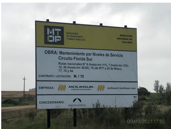
Ilustración 8 – P11, Empalme de rutas 76 y 77.
