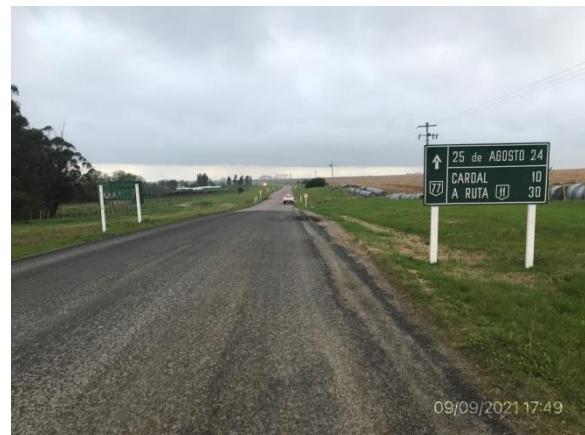
Ilustración 7 – Obras obligatorias de bacheo terminadas en Ruta 77.
