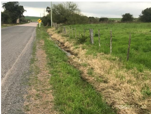
Ilustración 6 – Recuperación ambiental en ejecución en Ruta 76. Drenajes adecuados y empastado firme.
