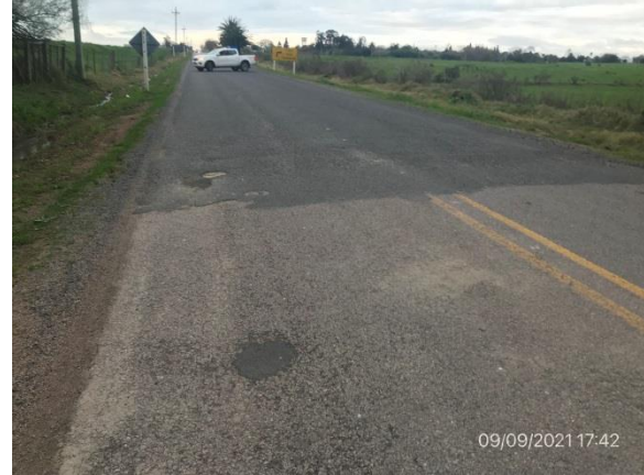
Ilustración 5 – Obras obligatorias de bacheo terminadas en Ruta 76.
