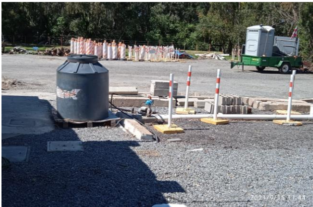
Ilustración 18 – P03, Obrador secundario. Tanque de agua para abastecimiento.
