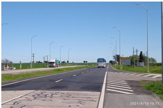
Ilustración 4 – P01, Inicio de obras.
