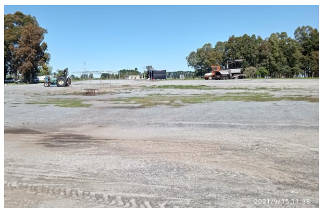
Ilustración 15 – P03, Obrador secundario. Zona donde se encontraba implantación de Planta Asfáltica.
