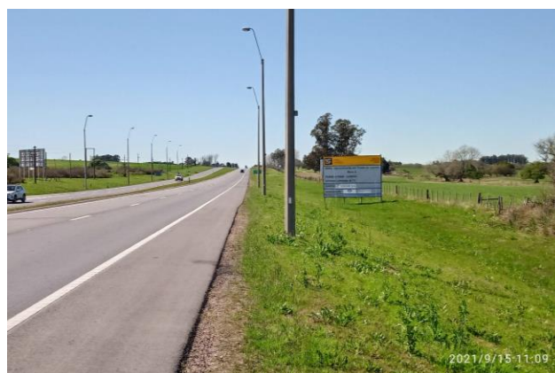
Ilustración 7 – P02, Fin de obras.
