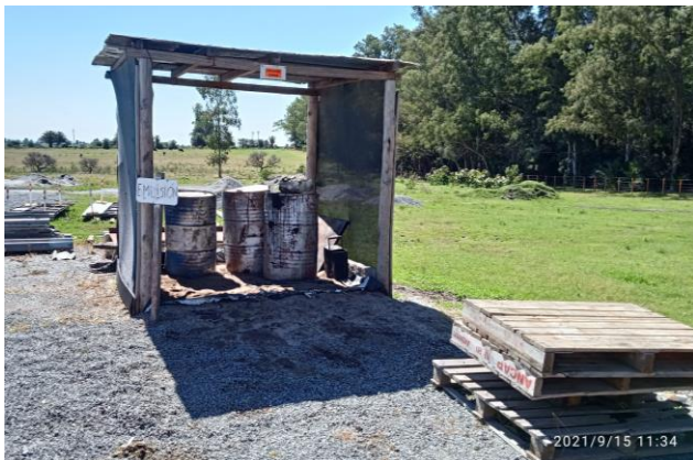
Ilustración 12 – P03, Obrador secundario. Depósito de emulsión.
