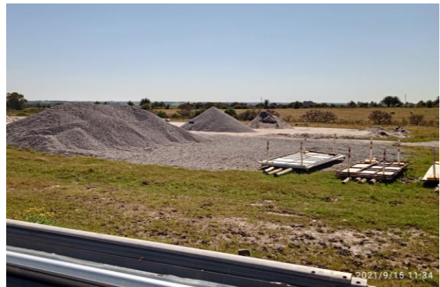
Ilustración 13 – P03, Obrador secundario. Zona de acopio de áridos.
