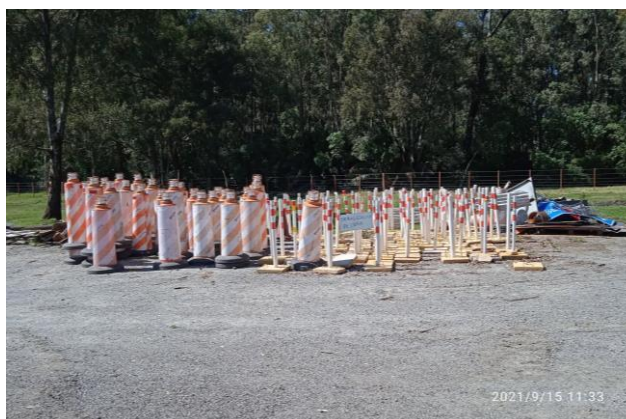
Ilustración 9 – P04, Obrador secundario. Zona de acopio de material para señalización de obra.
