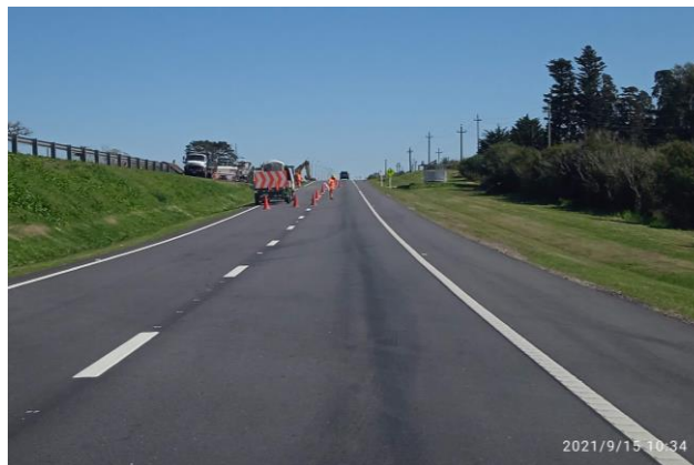
Ilustración 5 – Tareas de mantenimiento. Tarea de ensanche y reperfilado de cuentas realizado.
