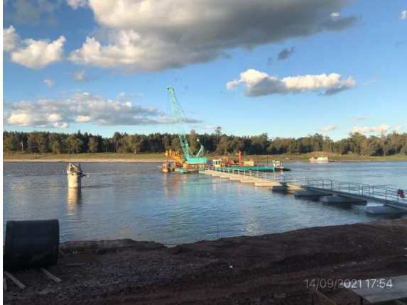
Ilustración 4 – P03, Puente en obra. Pontón flotante para pilotera y plataforma flotante de acceso.
