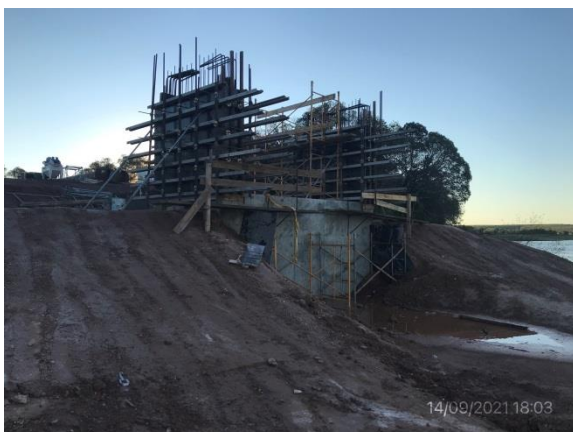
Ilustración 8 – P03, Puente en obra. Estribo margen Oeste en construcción.
