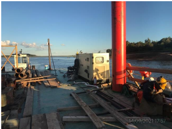
Ilustración 6 – P03, Puente en obra. Grupo electrógeno sobre pontón flotante.
