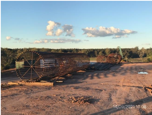
Ilustración 10 – P05, Obrador secundario. Explanada de acopio de armaduras de pilotes.
