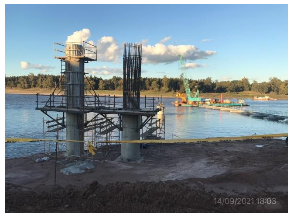
Ilustración 9 – P03, Puente en obra. Pilas de pórticos en construcción.
