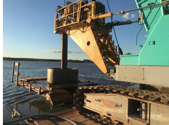
Ilustración 5 – P03, Puente en obra. Tareas de pilotaje entubado en ejecución sobre pontón flotante, subcontrato Piquetón SA.
