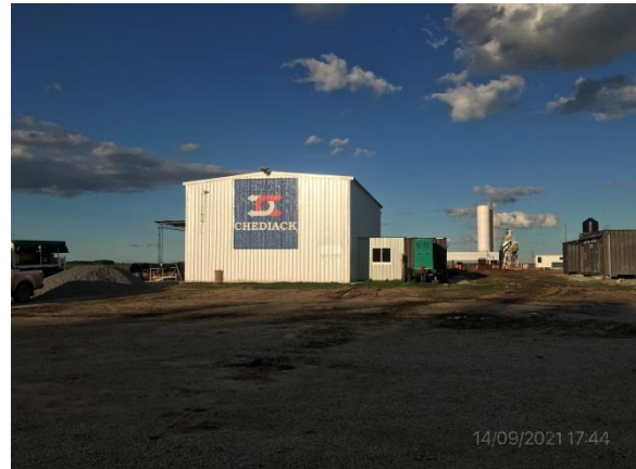
Ilustración 13 – P04, Obrador principal. Padrón N° 15.547 de la 9ª S.C. de Tacuarembó. Cno. La Balsa, progresiva 0K000, vista general.
