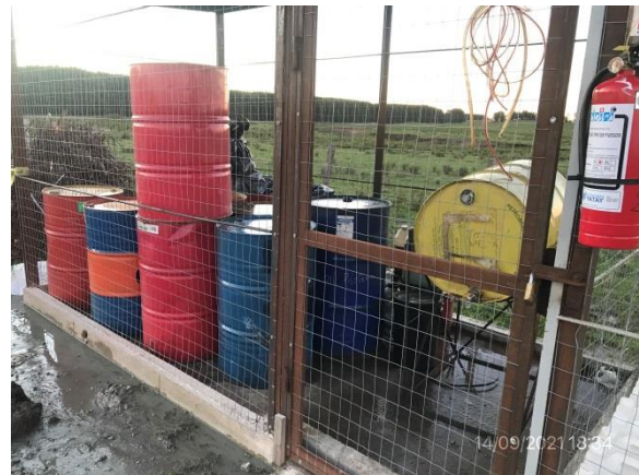
Ilustración 17 – P04, Obrador principal. Depósito techado y con envallado perimetral para hidrocarburos.
