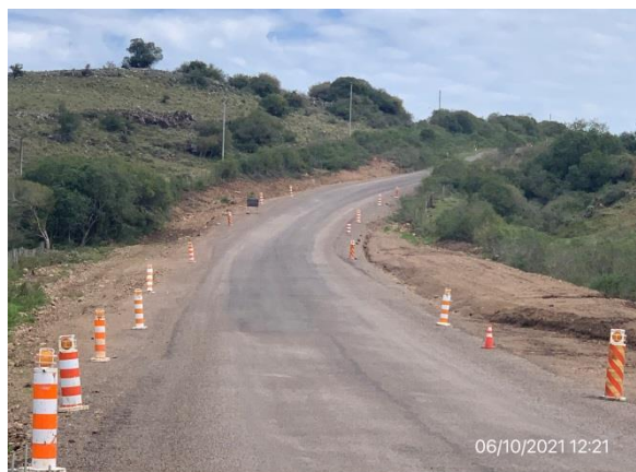
Ilustración 9 – P01. Ruta 31, acceso norte a alcantarilla terminado, restando obras de señalización.
