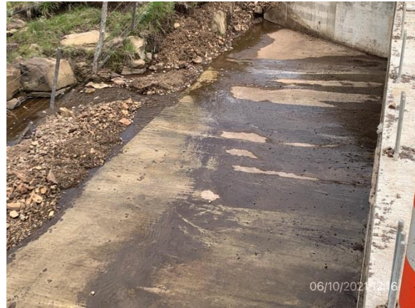
Ilustración 5 – P01. Alcantarilla tipo H terminada en Ruta 31, progresiva 186K400, sin restos de obra civil (ROCs).
