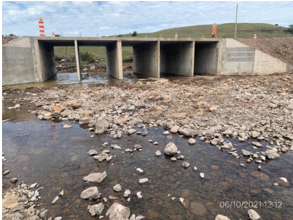
Ilustración 4 – P01. Alcantarilla tipo H terminada en Ruta 31, progresiva 186K400. Cauce con restauración ambiental culminada
