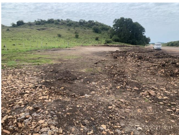
Ilustración 8 – P01. Obrador desmontado y con restauración ambiental realizada.
