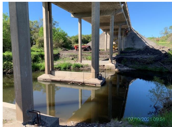
Ilustración 7 – P01, Puente sobre A° San Francisco G de . Nuevas riostras sobre cimientos existentes.
