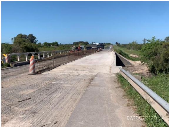
Ilustración 10 – P02, Puente sobre A° San Francisco Chico. Obras de refuerzo de tablero en medio tramo.
