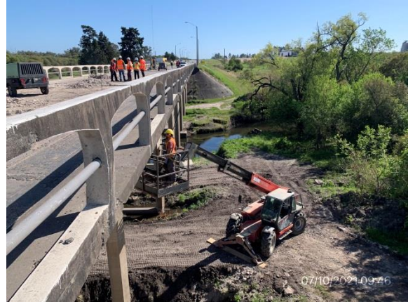
Ilustración 5 – P01, Puente sobre A° San Francisco G de . Obras de refuerzo de tablero en ejecución.
