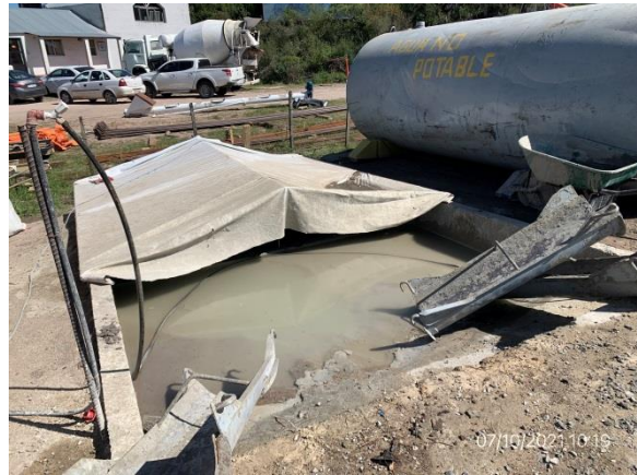
Ilustración 17 – P05, Obrador subcontratista Ingeniería Pacífico SA. Pileta de decantación de aguas de lavado de camiones míxer.
