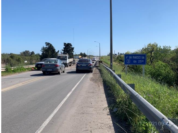
Ilustración 4 – P01, Puente sobre A° San Francisco G de . Obras en ejecución.
