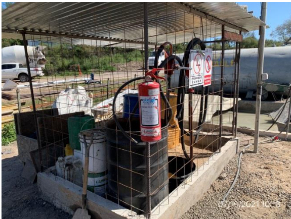
Ilustración 18 – P05, Obrador subcontratista Ingeniería Pacífico SA. Recinto techado y envallado para aceites y lubricantes.
