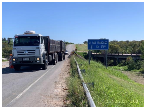
Ilustración 9 – P02, Puente sobre A° San Francisco Chico. Obras en construcción.
