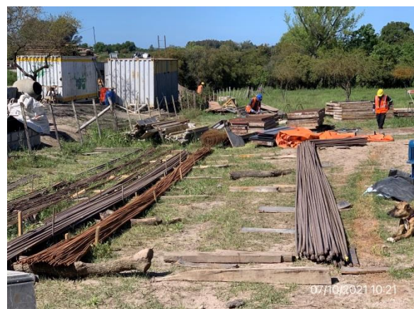
Ilustración 15 – P05, Obrador subcontratista Ingeniería Pacífico SA. Sector de preparación de armaduras.
