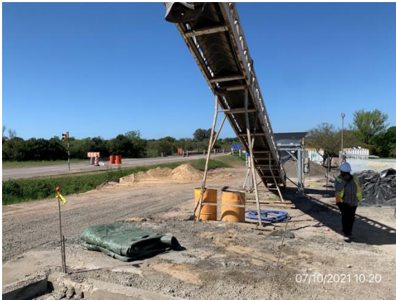
Ilustración 16 – P05, Obrador subcontratista Ingeniería Pacífico SA. Plata de hormigón.
