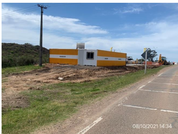
Ilustración 16 – P06, Obrador provisorio SACEEM.
