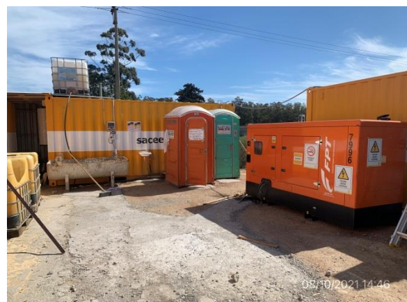
Ilustración 17 – P06, Obrador provisorio SACEEM. Generador estanco, baños químicos y depósito de agua no potable.
