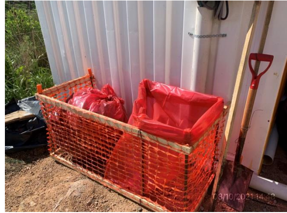
Ilustración 19 – P06, Obrador provisorio SACEEM. Depósito de residuos contaminados y peligrosos
