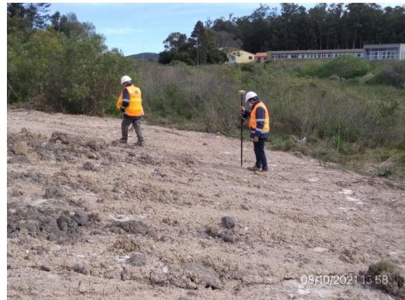
Ilustración 27 – P04. Zona de amortiguación de cañada utilizada para acopio de material de excavación en zona, Material retirado, sin protección vegetal
