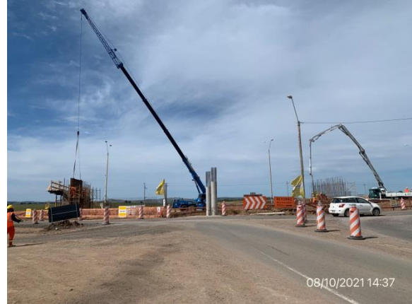
Ilustración 7 – P07 – Puente de intercambiador en obra, llenado en proceso
