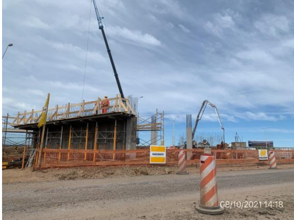
Ilustración 6 – P07 – Puente de intercambiador en obra, llenado en proceso
