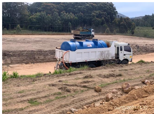
Ilustración 11 – Obras de terraplenado en vías de acceso a intercambiador.
