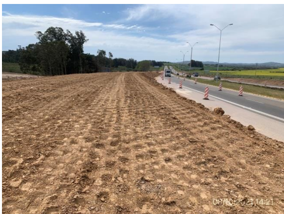
Ilustración 10 – Obras de terraplenado en vías de acceso a intercambiador.
