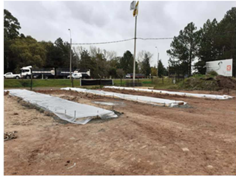
2-5 Plateas para construcción piezas prefabricadas consolidadas
