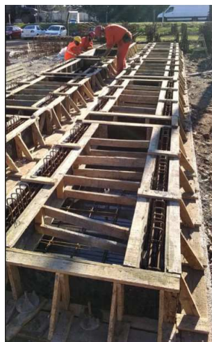
2-15 Proceso de colocación de armadura
