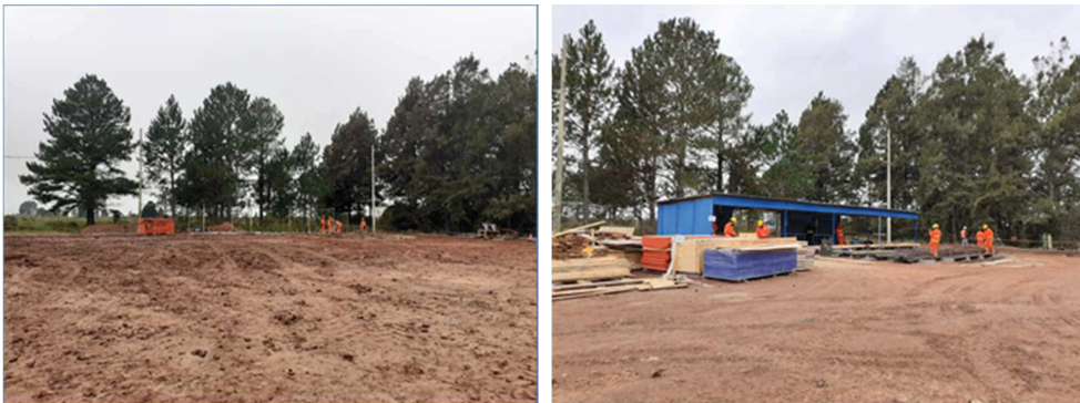
2-4 Proceso contractivo del banco de Herrería y carpintería
