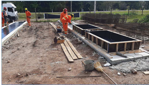
2-14 Posicionamiento de encofrado sobre cama
