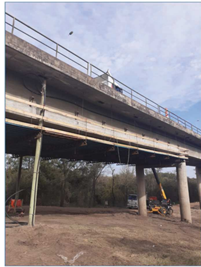
2-10 Tendido de monoducto de fibra telefónica
