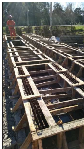
2-15 Proceso de colocación de armadura
