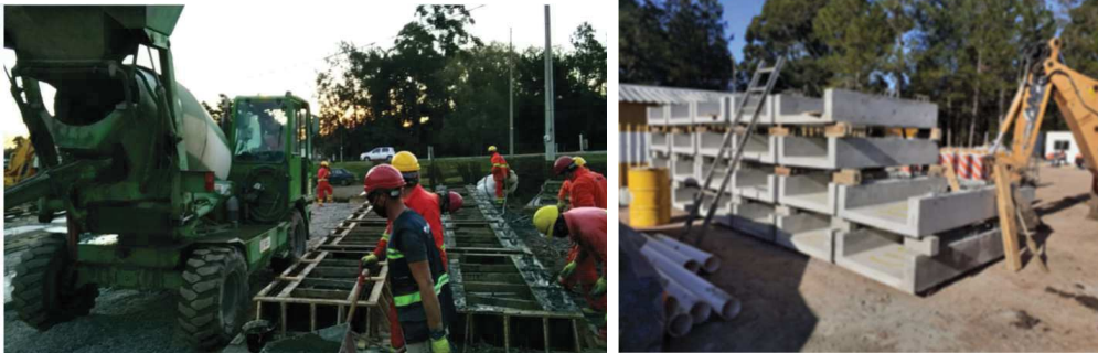
2-16 Proceso de llenado, vibrado; acopio de las piezas en centro de obrador
