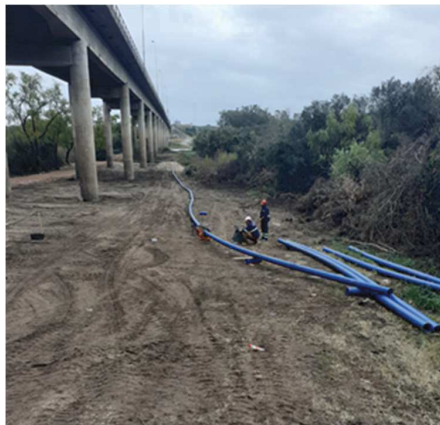
2-11 Soldeo de cañería para provisorio de OSE
