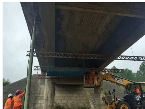
2-12 Montaje de ch cerchas y tablon de chapa
