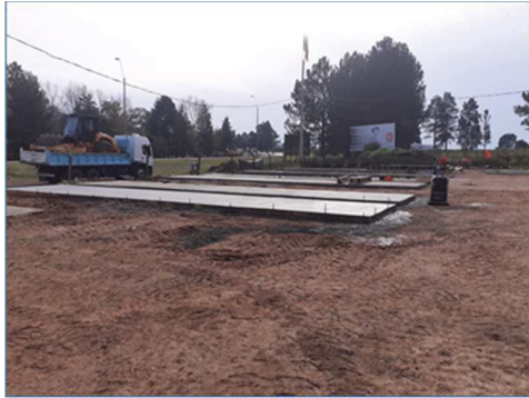
2-5 Plateas para construcción piezas prefabricadas consolidadas
