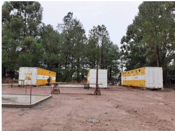
2-3 Proceso de instalación de comedor, vestuarios y pañol
