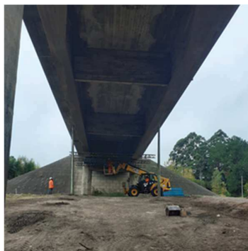
2-12 Montaje de ch cerchas y tablon de chapa
