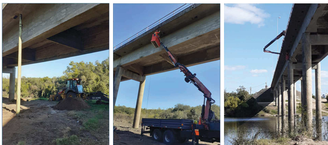
2-8 Columna por la que baja el cable en la cabecera y trabajo de perforaciones para el provisorio de UTE
