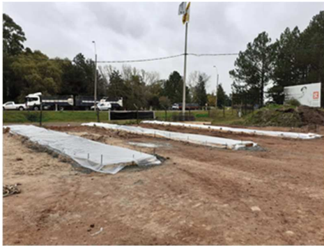
2-14 Posicionamiento de encofrado sobre cama
