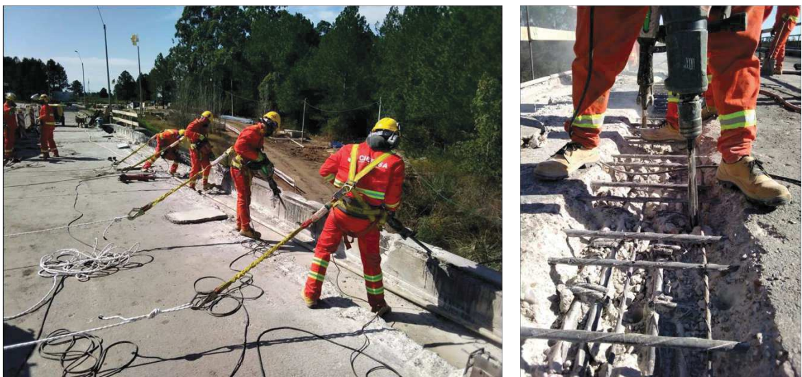
2-5 Trabajos con martillo para la demolición del cordón externo y picado para anclajes del tablero
