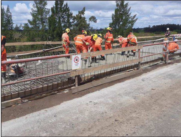
2-8 Llenado, vibrado, regleado y finalización.
