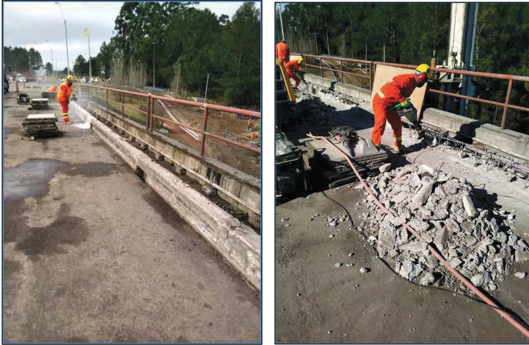
2-4 Corte y picado de cordón
