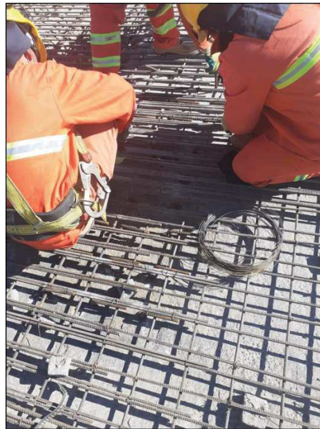
2-6 Armado de tablero y colocación de anclajes
