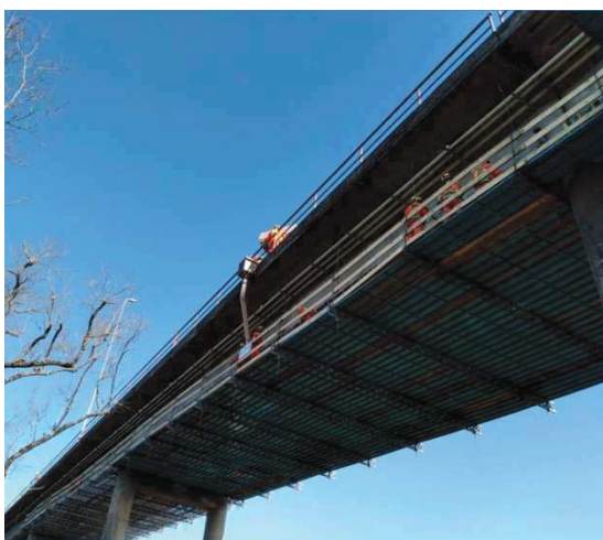
2-12 Llenado de viga longitudinal supertramo 2 vano 1; Retiro de plataforma en supertramo 1
