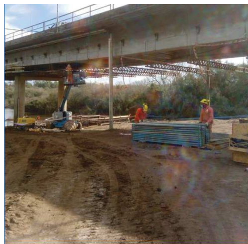
2-12 Llenado de viga longitudinal supertramo 2 vano 1; Retiro de plataforma en supertramo 1
