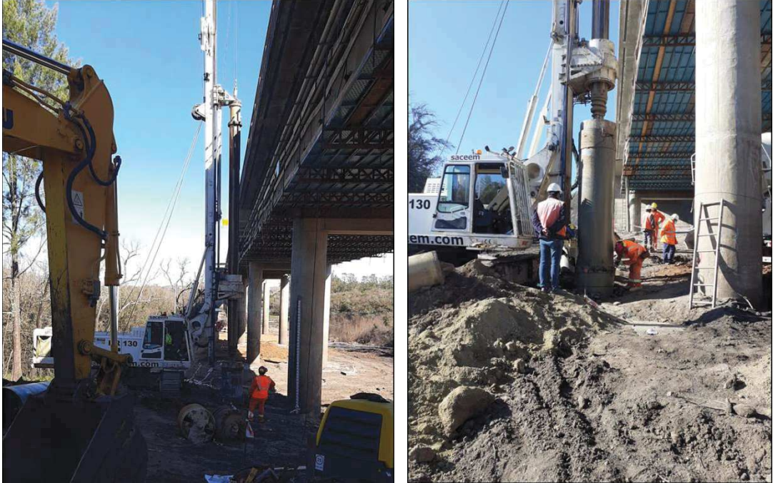
2-13 Ejecución de pilotes
