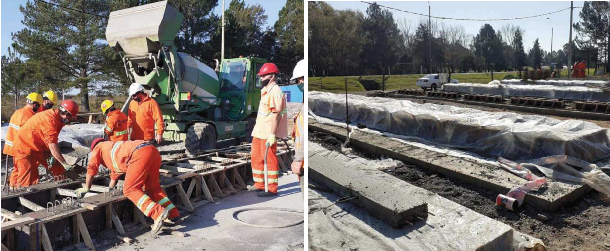
2-2 Hormigonado de piezas prefabricadas y curado de las mismas
