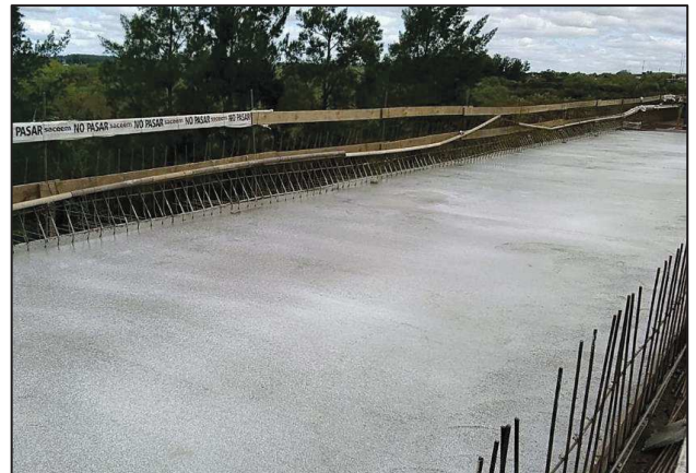
2-9 hormigonado del primer tramo finalizado
