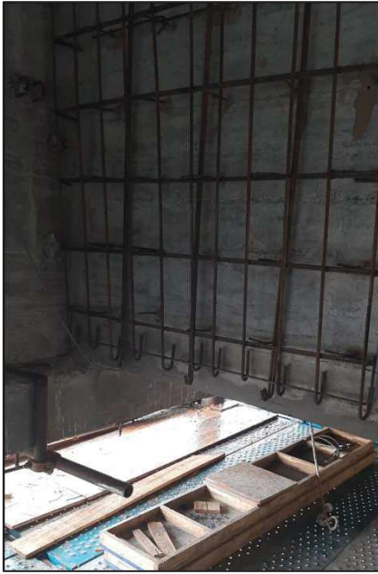
2-10 Armado de refuerzos transversales, colocación de piezas desviadoras
