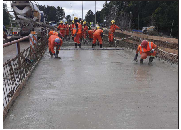
2-8 Llenado, vibrado, regleado y finalización.
