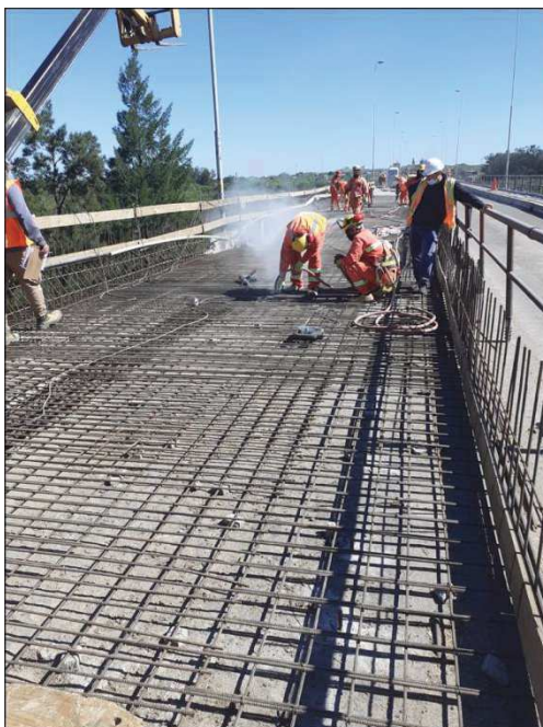
2-7 Limpieza para anclajes y tarea de recrecido para trompetas
