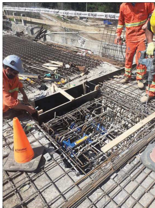
2-7 Limpieza para anclajes y tarea de recrecido para trompetas
