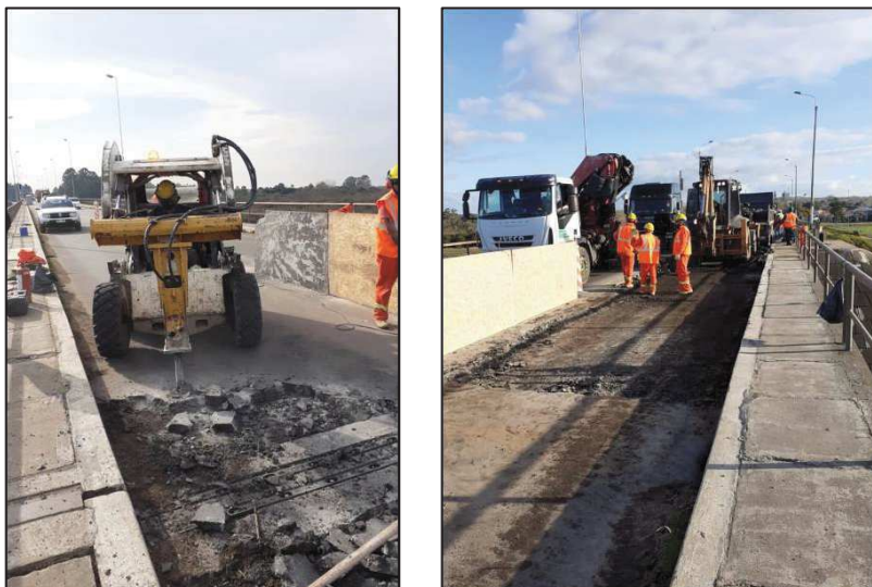
2-3 Picado y retiro de capa de rodadura
