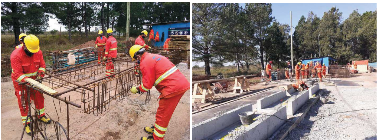
2-1 Armado de hierro y vista de patio de herrería y carpintería
