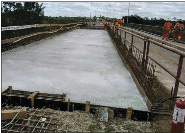
2-9 hormigonado del primer tramo finalizado
