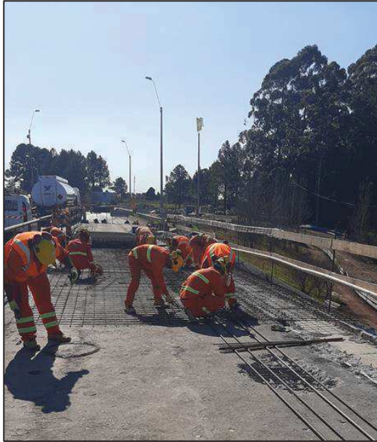
2-6 Armado de tablero y colocación de anclajes
