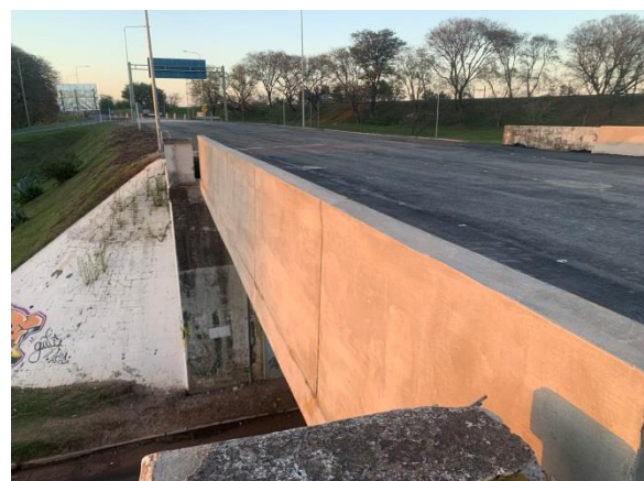
Ilustración 21 – P06, Pasaje superior sobre calle. Ruta 2 progresiva 279K060. Obras culminadas.
