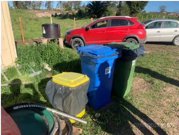
Ilustración 10 – P04, Pasaje superior sobre vía férrea. Campamento provisorio con infraestructura para gestión de residuos segregados.
