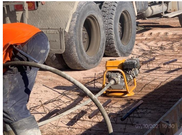
Ilustración 7 – P05, Pasaje superior sobre calle. Vibrador en funcionamiento sin contención para prevención de derrames.
