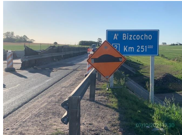
Ilustración 11 – P02, puente sobre A° Bizcocho en ejecución. Ruta 2 progresiva 251K200.
