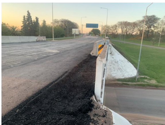
Ilustración 20 – P06, Pasaje superior sobre calle. Ruta 2 progresiva 279K060. Obras culminadas.
