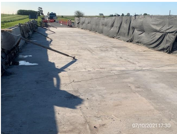
Ilustración 12 – P02, puente sobre A° Bizcocho. Obras de ensanche de tablero en ejecución
