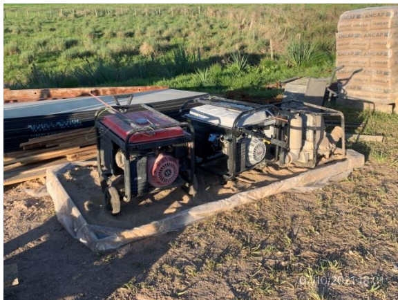
Ilustración 18 – P01, Puente sobre A° La Lancha. Equipos portátiles con bandejas impermeables de contención anti derrames.
