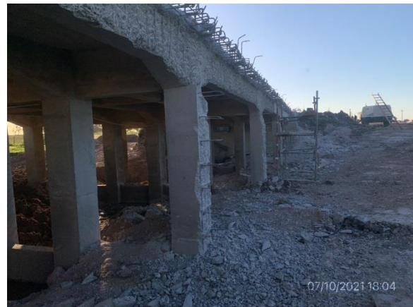
Ilustración 17 – P01, Puente sobre A° La Lancha. No están marcadas las zonas de máxima creciente.
