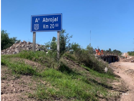
Ilustración 4 – P02, puente sobre A° Abrojal. Frente de Obras en ejecución.
