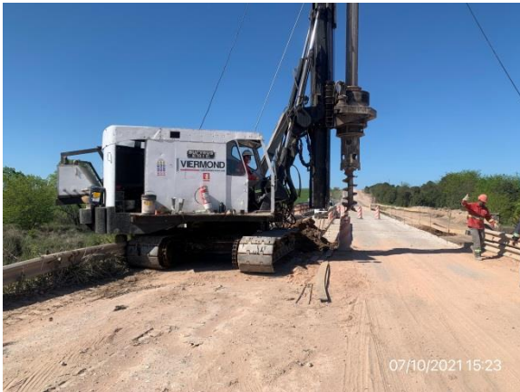
Ilustración 10 – P01, puente sobre A° Totoral. Subcontrato de ejecución de pilotaje de parte de Viermont SA.
