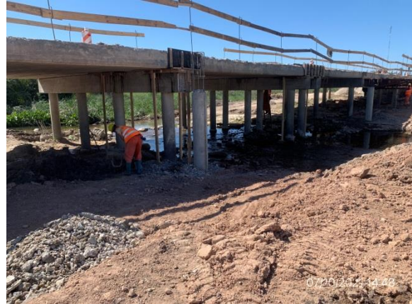
Ilustración 5 – P02, puente sobre A° Abrojal. Nuevos cimientos y pilares construidos. No están indicadas las zonas de máxima creciente
