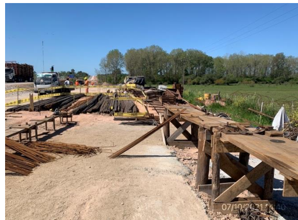
Ilustración 13 – P02, obrador principal. Zona de preparación de armaduras.
