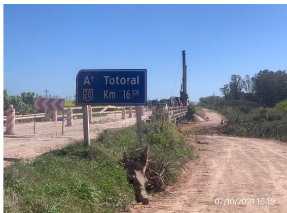
Ilustración 9 – P01, puente sobre A° Totoral. Frente de Obras en ejecución.
