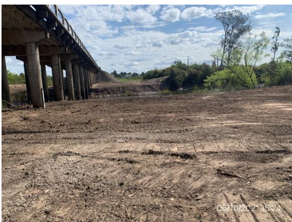
Ilustración 14 – P01, Puente sobre en Río Tacuarembó Chico. Ruta 5 progresiva 390K170. Explanada acondicionada para futuro campamento provisorio.
