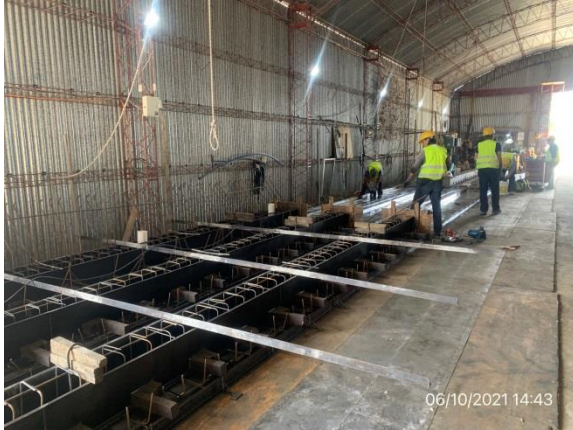
Ilustración 4 – P04, Obrador subcontratista Olecor SA Sector de llenado de vigas prefabricadas.
