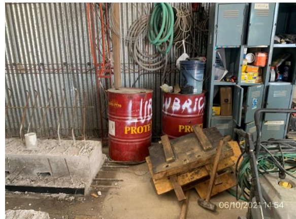
Ilustración 7 – P04, Obrador subcontratista Olecor SA. Acopio de lubricantes bajo techo pero alojados en recinto sin estanqueidad para prevenir derrames.
