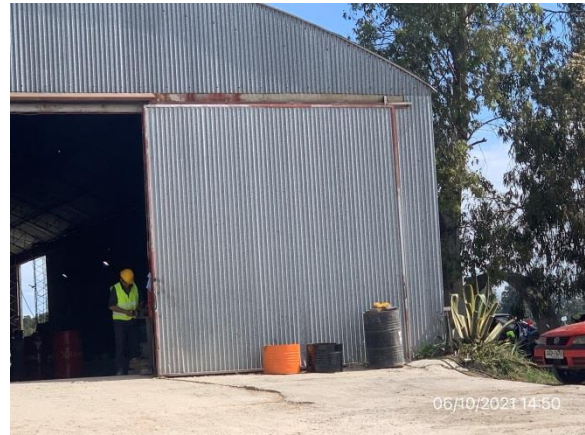
Ilustración 11 – P04, Obrador subcontratista Olecor SA Estación de acopio de residuos segregados por corriente de generación.
