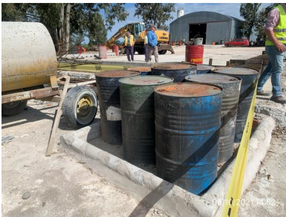
Ilustración 12 – P04, Obrador subcontratista Olecor SA. Recinto de lubricantes usados con envallado perimetral.
