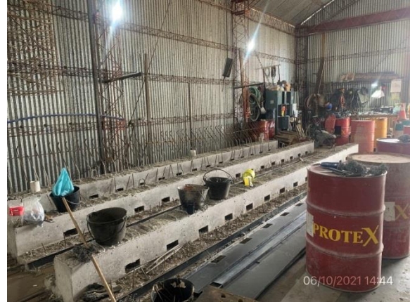
Ilustración 5 – P04, Obrador subcontratista Olecor SA Vigas prefabricadas construidas.
