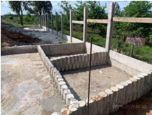
Ilustración 10 – P04, Obrador subcontratista Olecor SA.
