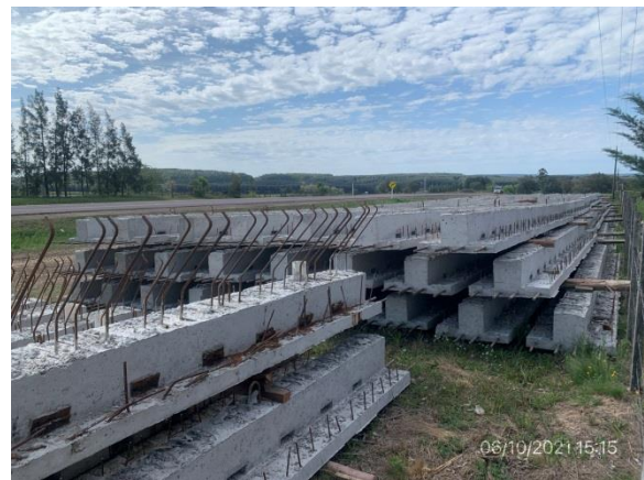
Ilustración 13 – Depósito de vigas prefabricadas construidas. Faja pública de Ruta 5, PK 396K000 a (+)
