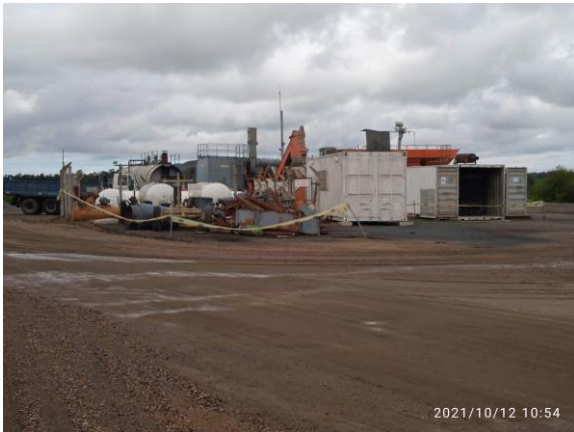
Ilustración 12 – P05, Obrador. Zona de acopio de materiales correctamente delimitada.
