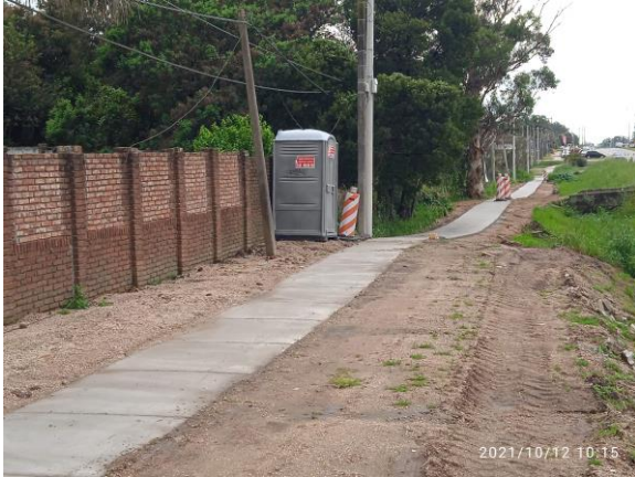
Ilustración 4 – Obras en ejecución en sendero peatonal en Ruta 8.
