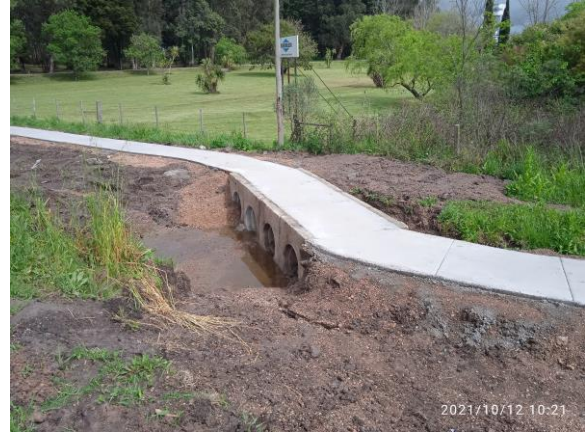
Ilustración 5 – Obras en ejecución en sendero peatonal en Ruta 8.
