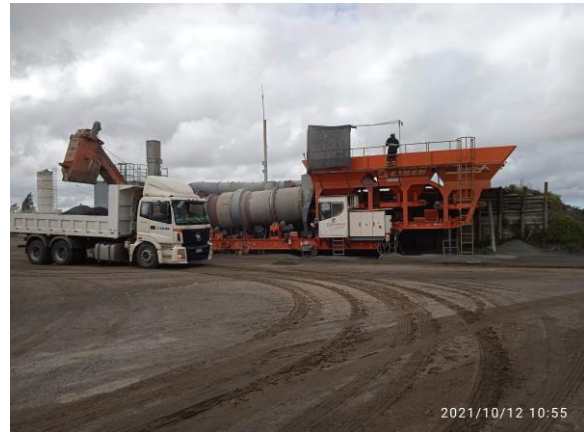
Ilustración 13 – P05, Obrador. Planta asfáltica con contención perimetral.
