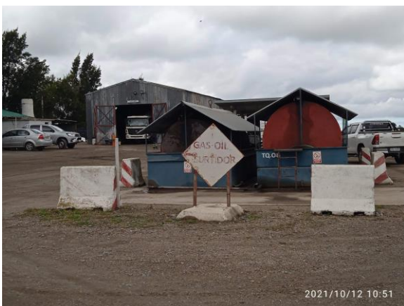
Ilustración 8 – P05, Obrador. Depósito de combustible correctamente techado y con envallado perimetral.
