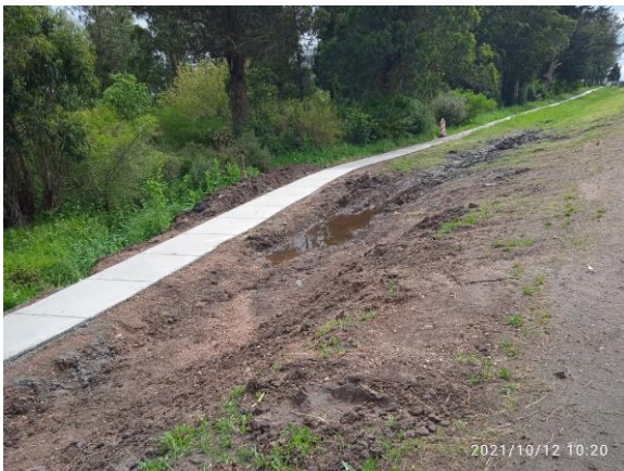
Ilustración 6 – Obras en ejecución de sendero peatonal en Ruta 8.
