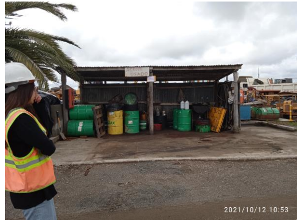
Ilustración 11 – P05, Obrador. Depósito de aceites usados techado y con envallado perimetral.
