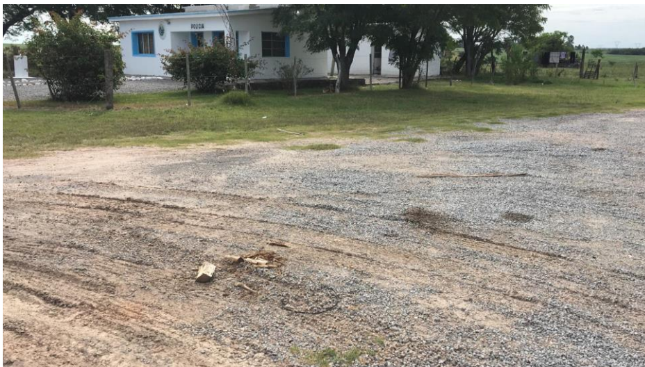
Relevamiento fotográfico del obrador – Padrón N°3.970
