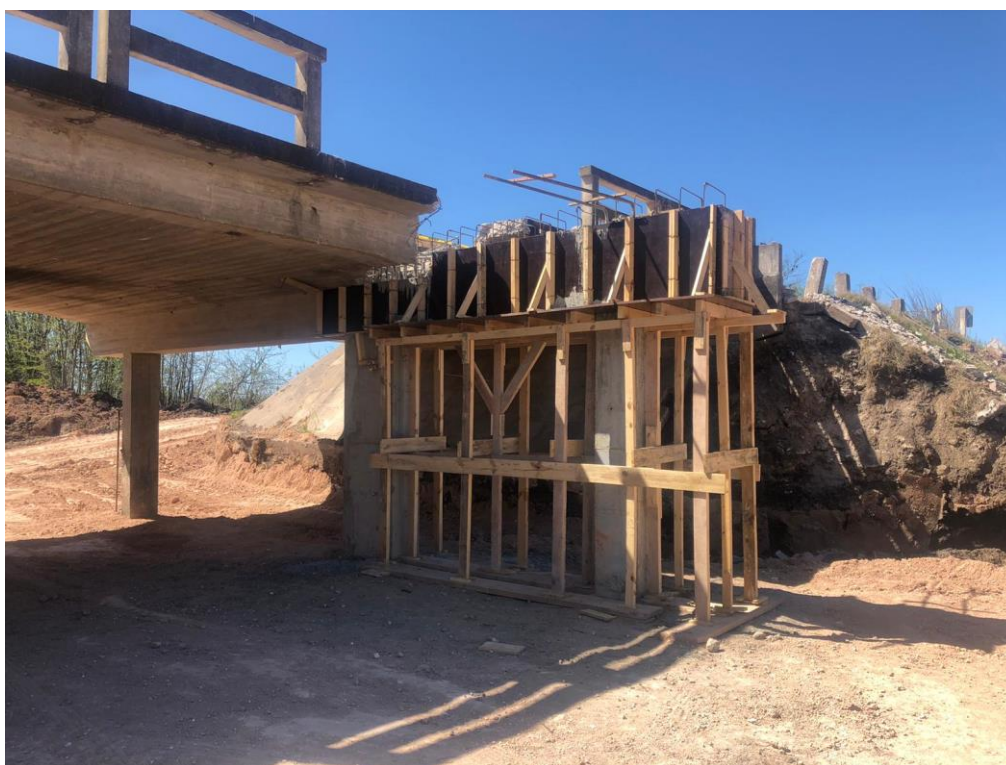
Ejecución de los trabajos – Puente Cda Del Sauce
