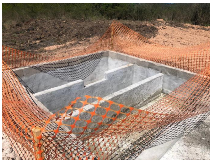
Pileta de lavado en construcción
