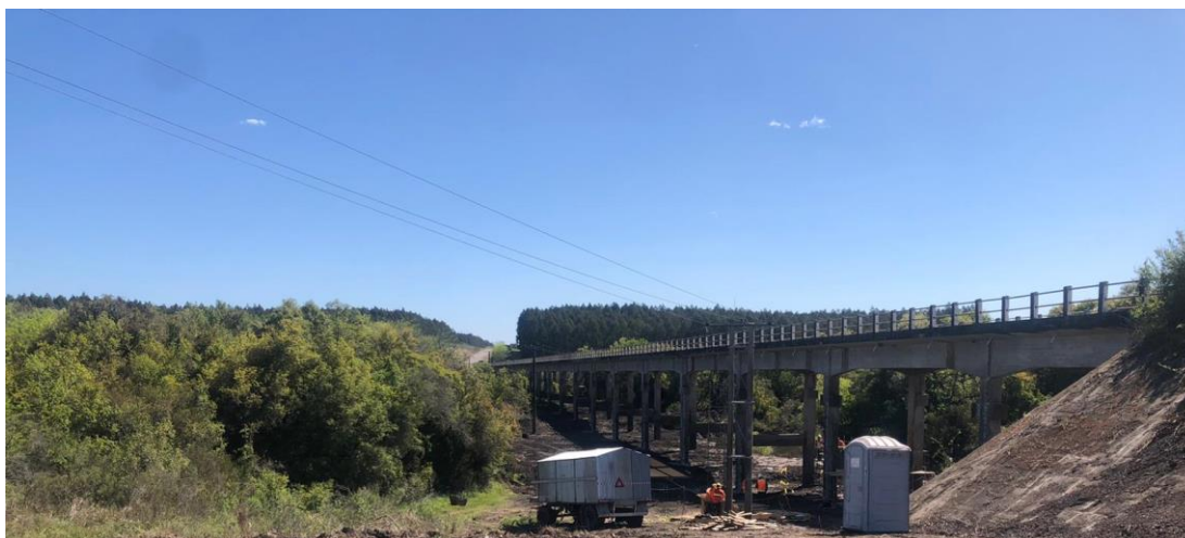
Ejecución de los trabajos – Puente Aº Don Esteban
