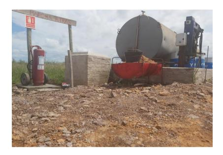
DEPOSITO DE COMBUSTIBLE CENTRAL EN OBRADOR (con contención por derrames, dispositivos para posibles accidentes y derrames, extinguidor y pileta para extracción de aguas pluviales).
