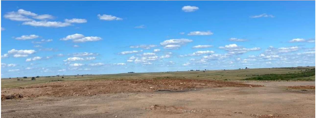
Vista de Rampa y zona de planta asfáltica.
