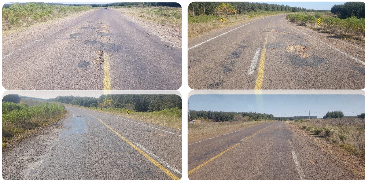
Figura 12 - Vistas del tramo
