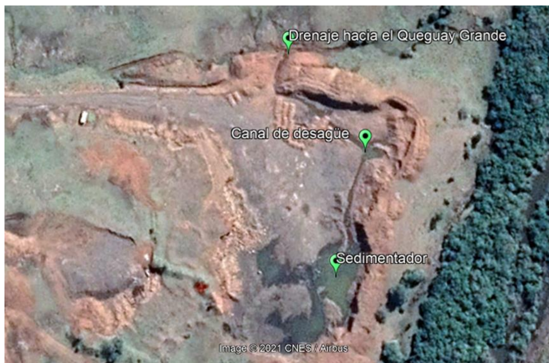
Figura 13 - Drenaje Cantera de piedra
