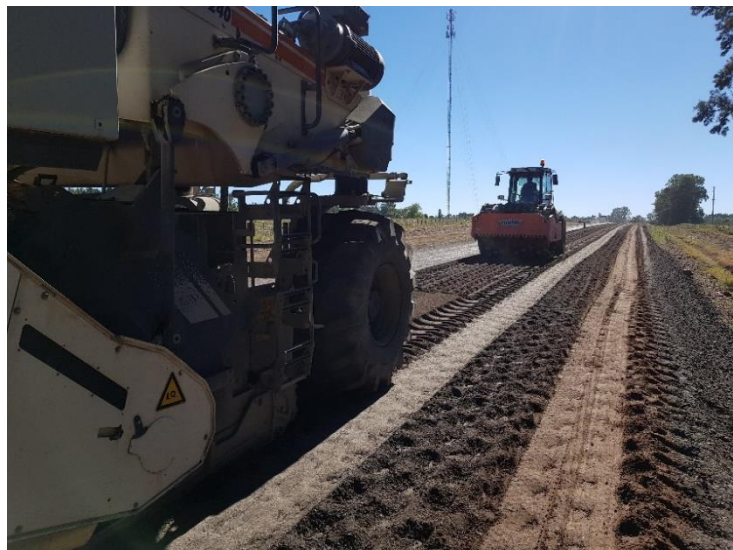
Figura 5 - Reciclado de pavimento existente
