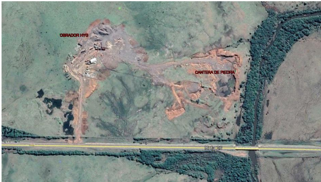
Figura 2 - Vista del Obrador y Cantera
