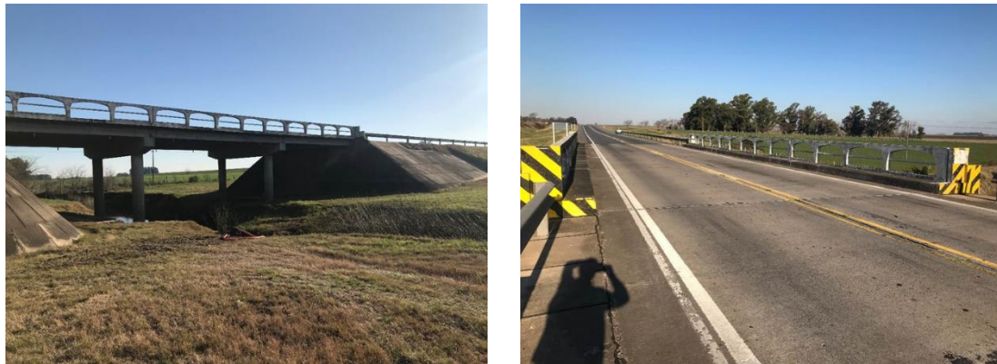
Figura 4-2 Imágenes del puente arroyo Bizcocho
