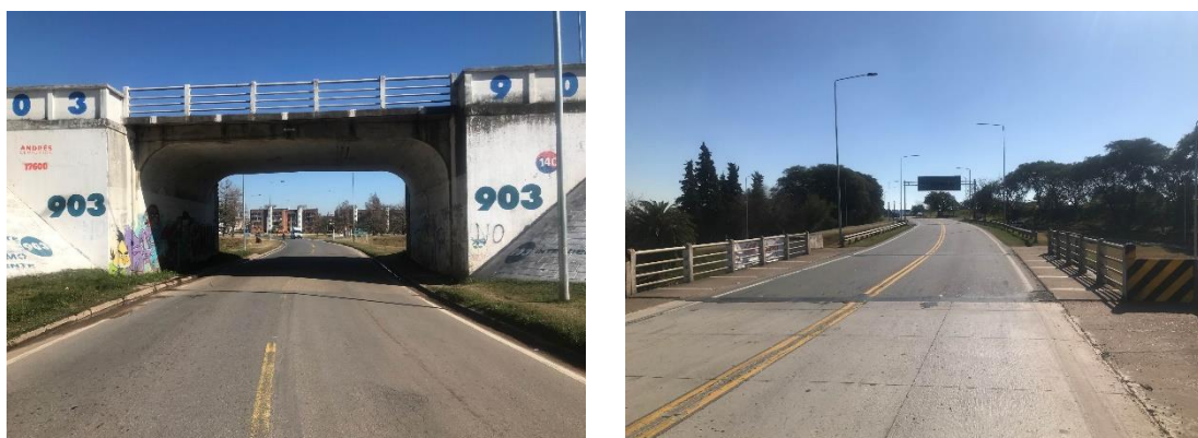
Figura 4-6 Imágenes de puente sobre Ruta 14
