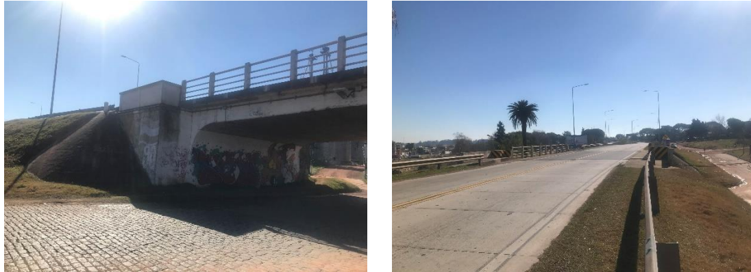
Figura 4-5 Imágenes de puente calle de la ciudad de Mercedes
