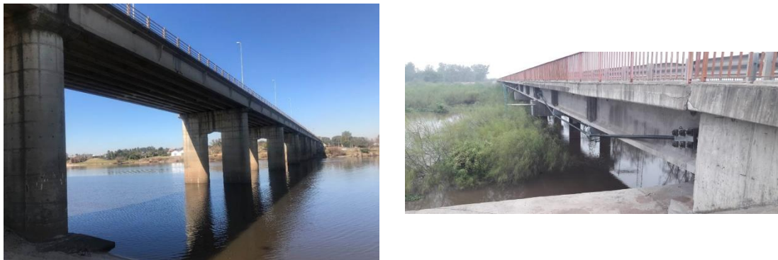
Figura 4-9 Imágenes del puente sobre el río Negro (ciudad de Mercedes)
