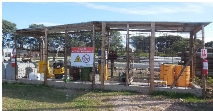
Figura 4-1 Recinto de sustancias peligrosas.
