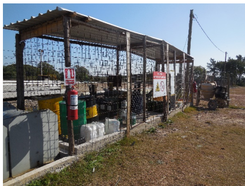
Figura 3-4 Recinto de almacenamiento de combustible.
