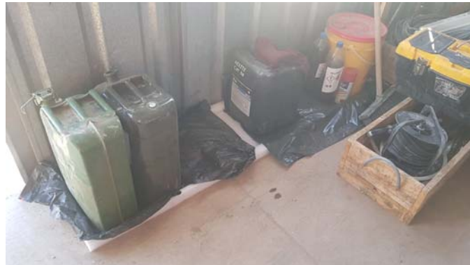
Figura 3-4 Recinto de almacenamiento de combustible en obrador principal y bidones de combustible en campamento
