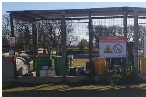
Figura 6-3 Recinto de Acopios de residuos peligrosos.
