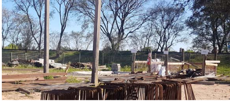
Figura 6-2 Corralitos para ROCs en obrador principal.
