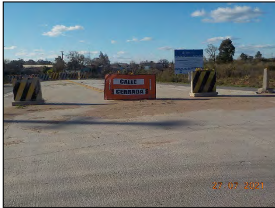
Culminación de la obra preexistente del By Pass de Nueva Palmira e inicio del proyecto.
