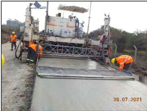
Ejecución de pavimento de hormigón en calle Paysandú (julio '21).
