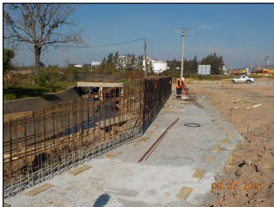
Ejecución de muro de contención en calle Baygorria.
