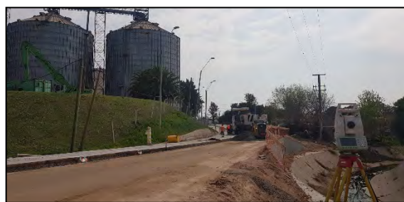
Ejecución de pavimentación en By Pass (agosto '21)..
