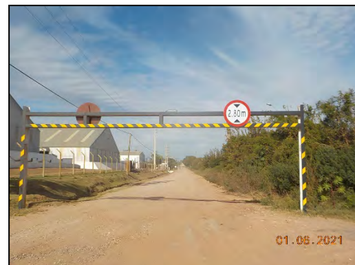
Pórtico retirado en calle Ordoñana para reconstrucción de la misma (junio '21)..
