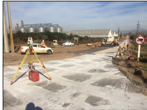
Construcción de pavimento de hormigón en calle Ordoñana y Ruta 12 (julio '21)..
