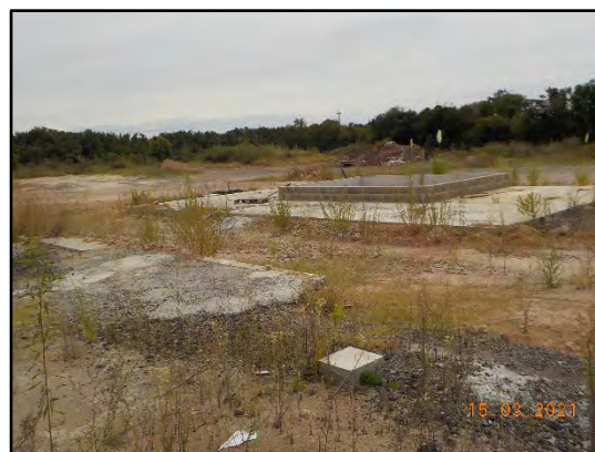
Zona en dónde se ubican viejas bases de una planta de hormigón, que serán utilizadas para la nueva planta.
