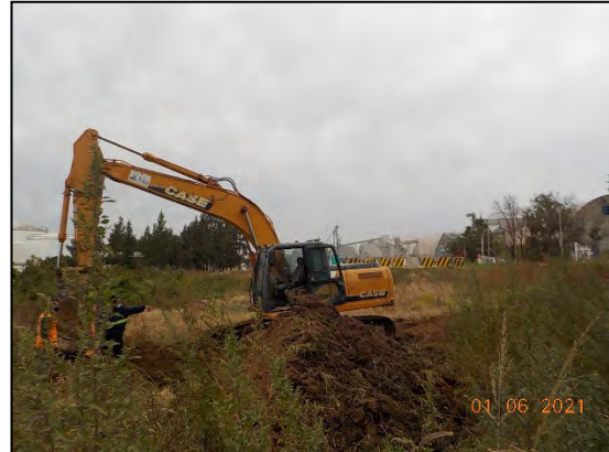
Inicio de obra de suelos en By Pass (junio '21)..
