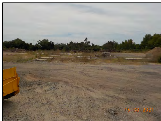
Camino de acceso a los acopios.
