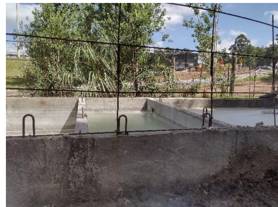
Ilustración 13-Piletas para el lavado de hormigonera.
