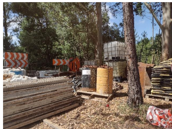
Ilustración 9-Acopia de materiales y herramientas. En esta imagen se puede ver como se mantuvo la vegetación del obrador.
