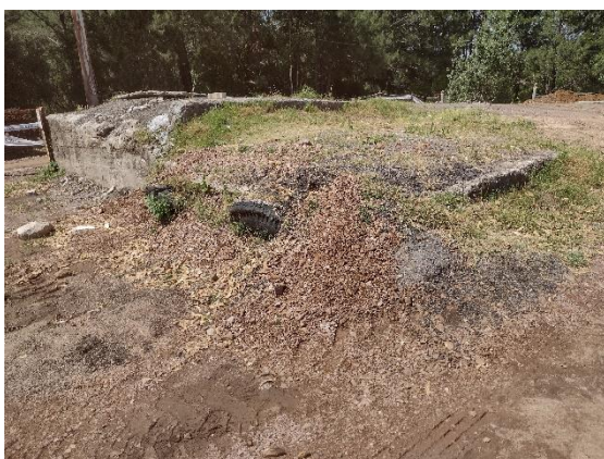
Ilustración 20-Antiguos escombros en la faja pública, entre obrador y frente de obras.
