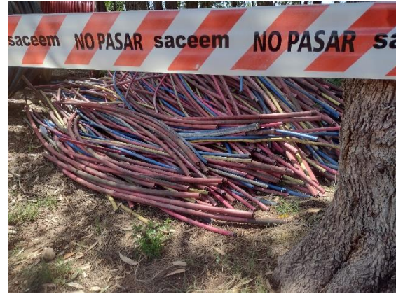
Ilustración 11-Señalización en zona de acopio de materiales. Cables eléctricos en desuso.
