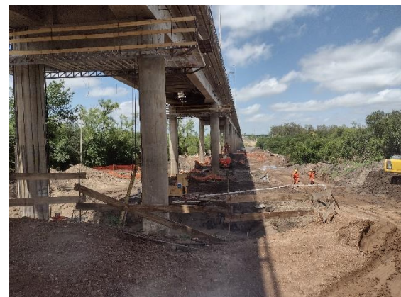
Ilustración 15-Frente de obra, trabajos bajo el puente.
