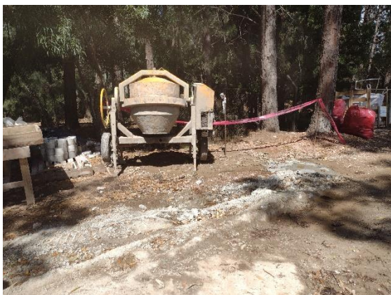
Ilustración 8-Acopia de materiales y herramientas, con señalización correspondiente.
