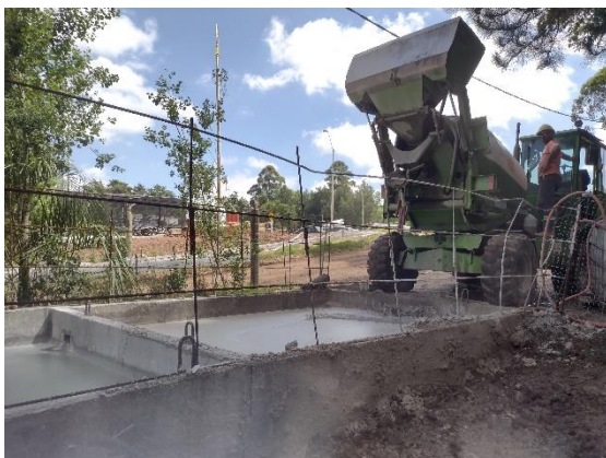
Ilustración 14-Piletas para el lavado de hormigonera.
