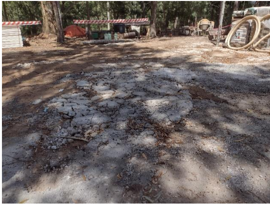
Ilustración 10-Acondicionamiento del suelo para facilitar la circulación.
