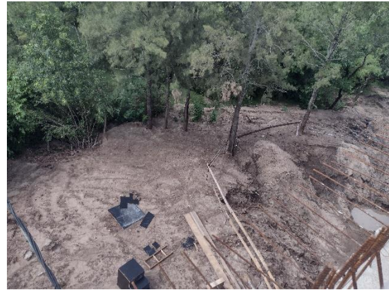
Ilustración 17-Frente de obra, trabajos bajo el puente.
