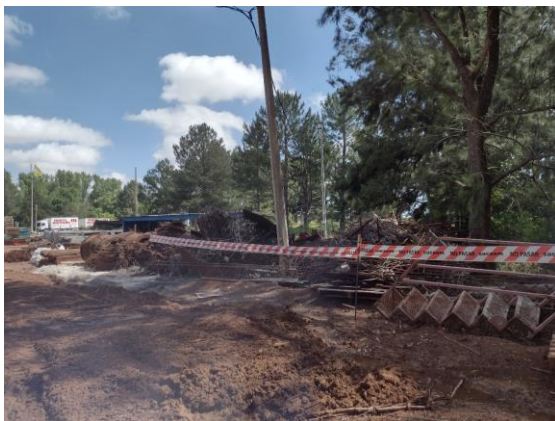
Ilustración 12-Señalización en zona de acopio de materiales.
