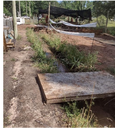
Ilustración 5-Canaleta construida en el obrador para separar aguas que ingresan desde predio más alto.
