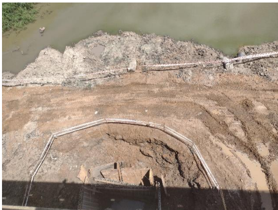
Ilustración 18-Frente de obra, trabajos bajo el puente.
