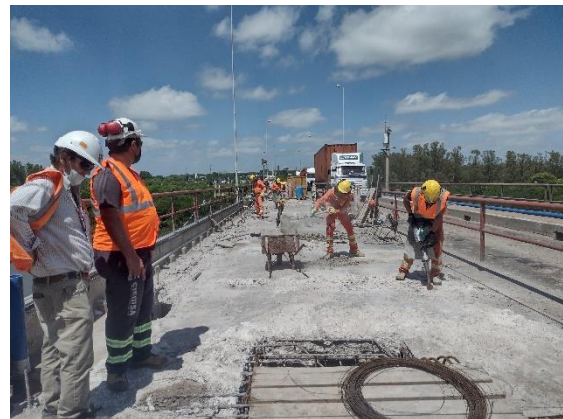
Ilustración 19-Frente de obra, trabajos sobre el puente.
