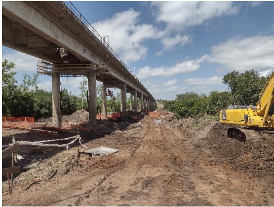
Ilustración 16-Frente de obra, trabajos bajo el puente.
