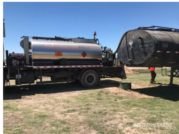
Ilustración 13 – P05, Campamento provisorio. Ruta 20 progresiva 13K700 a (+). Acopio de emulsiones asfálticas sin protección para prevención de derrames.
