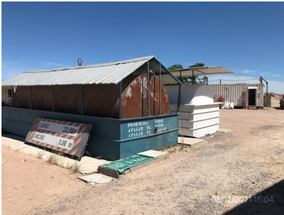
Ilustración 16 – P06, Obrador principal. Depósito de combustible con envallado perimetral
