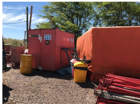
Ilustración 15 – P06, Obrador principal. Sector de obrador destinado a subcontratista Wajery SA, sector de acopio de residuos ordenados y segregados.
