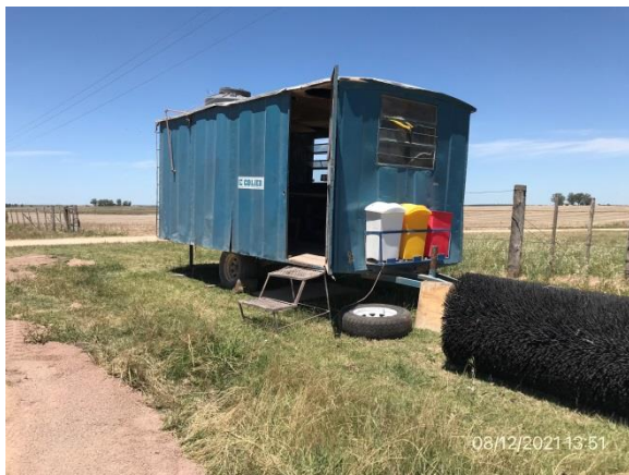
Ilustración 12 – P05, Campamento provisorio. Ruta 20 progresiva 13K700 a (+). Estación de baños y acopio de residuos en buenas condiciones.
