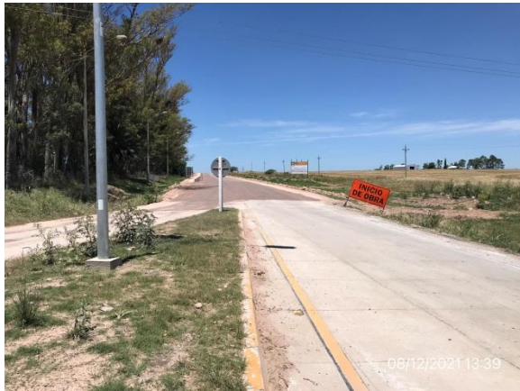
Ilustración 4 – P01, Inicio de tramo. Ruta 20, progresiva 9K500.
