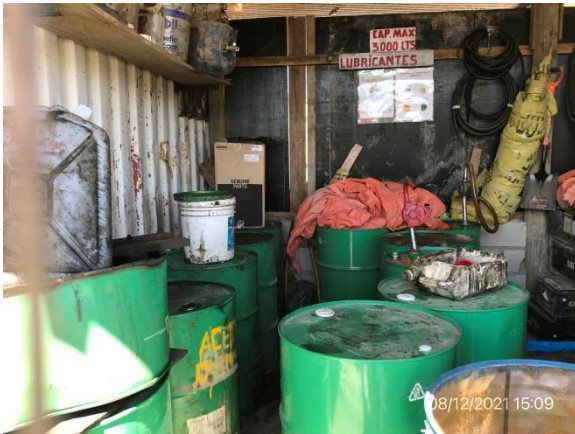
Ilustración 18 – P06, Obrador principal. Acopio de lubricantes en sector con pavimento y envallado impermeables.
