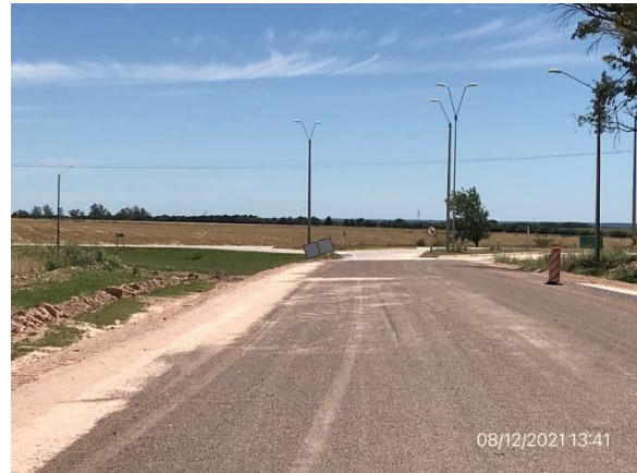
Ilustración 5 – P01, Inicio de tramo. Ruta 20, progresiva 9K500.
