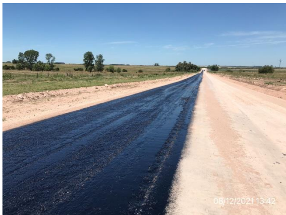
Ilustración 6 – Ruta 20, obras en ejecución. Base granular con imprimación terminada.
