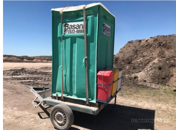
Ilustración 23 – P03, Cantera de balasto. Ruta 20 progresiva 20K000 a (+), Baño químico y estación de residuos
