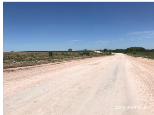
Ilustración 7 – Ruta 20, obras en ejecución. Base granular con imprimación terminada.
