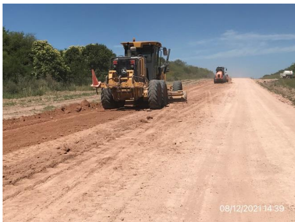
Ilustración 8 – P04, Frente de obra. Ruta 20, progresiva 29K800. Trabajos de perfilado en ejecución.
