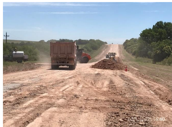
Ilustración 9 – P04, Frente de obra. Ruta 20, progresiva 29K800. Trabajos de recargo granular en ejecución. Material particulado volátil en abundancia.
