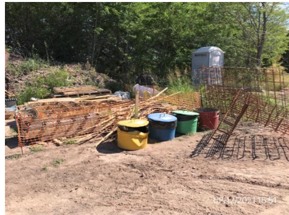
Ilustración 7 – P01, Campamento provisorio en puente sobre C da del Sauce. Estación para acopio de residuos.
