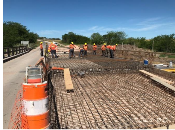
Ilustración 5 – P01, Puente sobre C da del Sauce Trabajos en tablero superior en ejecución.
