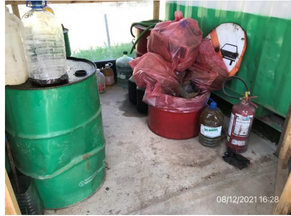
Ilustración 17 – P04, obrador principal. Depósito de lubricantes con pavimento impermeable pero sin envallado perimetral para prevención de derrames.
