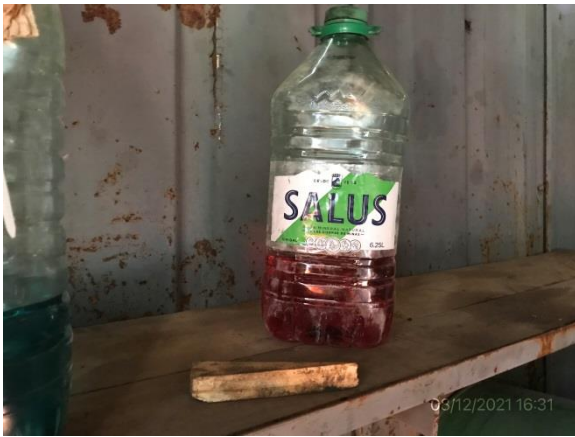
Ilustración 18 – P04, obrador principal. Combustible en bidón con cartelera inapropiada.
