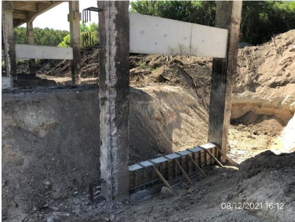
Ilustración 10 – P02, Puente sobre A° Don Esteban. Refuerzo de cimientos en ejecución.
