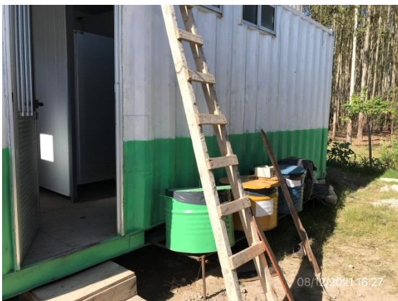
Ilustración 14 – P04, obrador principal. Estación para acopio de residuos segregados según tipo.
