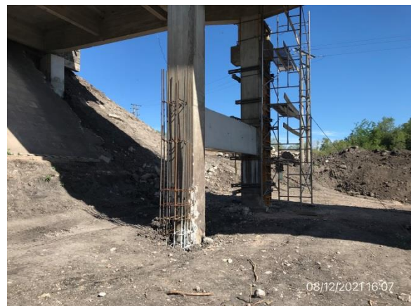
Ilustración 9 – P02, Puente sobre A° Don Esteban. Recreido de pilares en ejecución.
