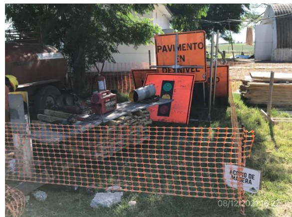
Ilustración 15 – P04, obrador principal. Sector de depósito de cartelería vial.
