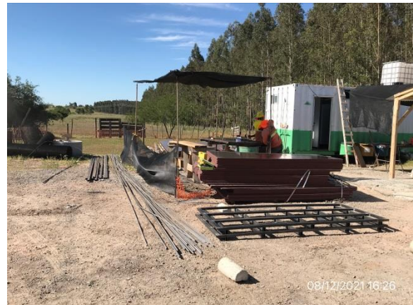
Ilustración 13 – P04, obrador principal. Zona de taller de armaduras y encofrados.
