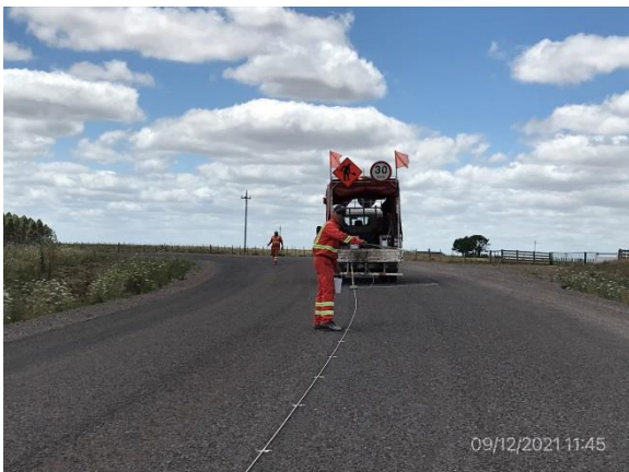
Ilustración 20 – P04, Frente de obras. Ejecución de tareas de señalización por subcontratista Bordonix SA. Ruta 59 progresiva 6K100.
