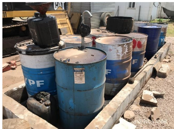
Ilustración 9 – P03, Obrador principal. Tarrinas de aceites usados en explanada con envallado perimetral.
