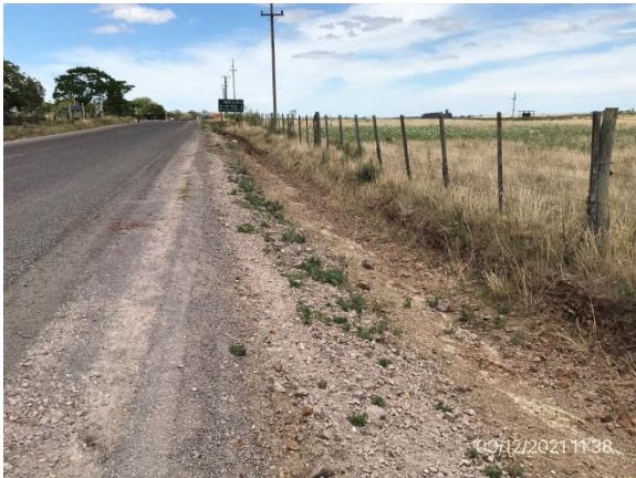
Ilustración 18 – Ruta 59. Drenajes adecuados con empastado incipiente en taludes.
