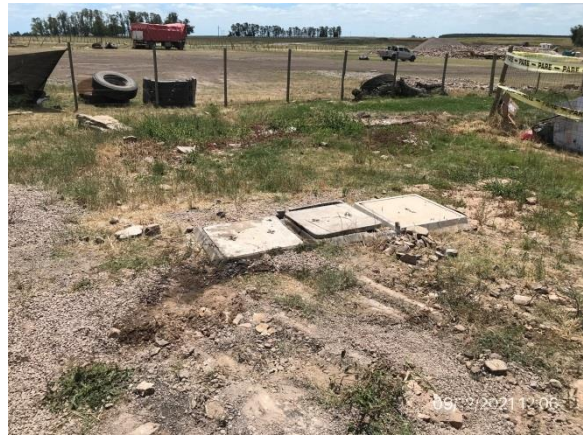
Ilustración 11 – P03, Obrador principal. Trampa de grasas y aceites proveniente de envallado de tarrinas de aceites usado y de explanada de taller mecánico.
