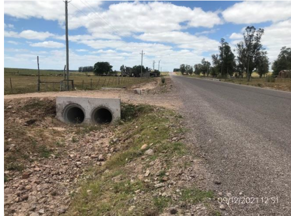
Ilustración 17 – Ruta 59. Drenajes y entradas particulares ejecutados.
