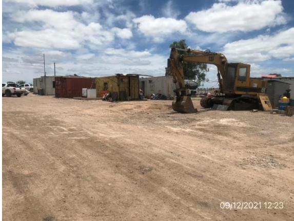
Ilustración 4 – P03, Obrador principal.
