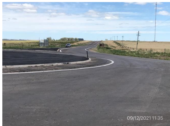
Ilustración 15 – P01, Inicio de tramo. Empalme de Ruta 43 con Ruta 59.
