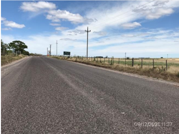
Ilustración 16 – Ruta 59. Trabajos viales terminados a la espera de obras de señalización.
