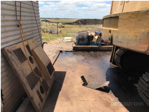
Ilustración 10 – P03, Obrador principal. Explanada impermeable para taller de maquinaria.
