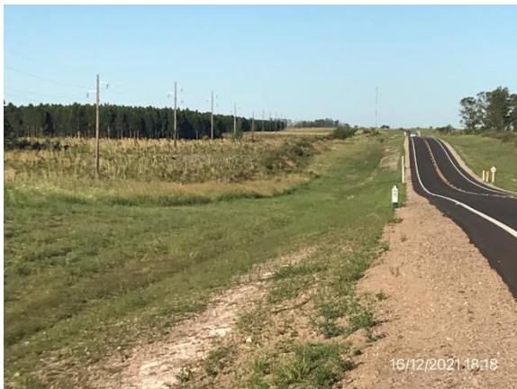
Ilustración 6 – Obras terminadas en tramo de Ruta 26. Drenajes ejecutados y empastado en crecimiento en cunetas.
