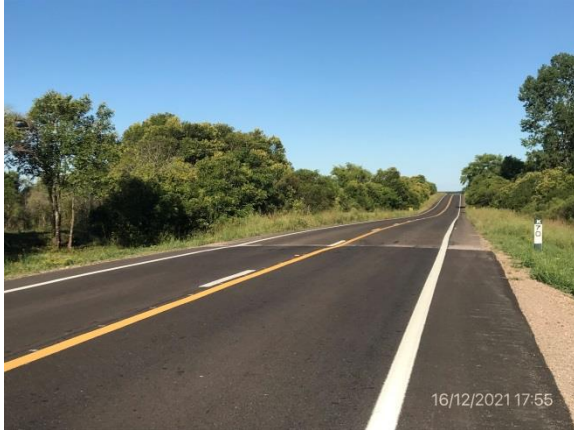
Ilustración 4 – P02, Fin de tramo. Ruta 26, progresiva 70K000
