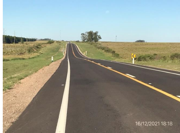
Ilustración 5 – Obras terminadas en tramo de Ruta 26. Carpeta asfáltica ejecutada
