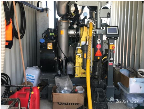
Ilustración 10 – Puente de Ruta 2 sobre el río Negro, campamento superior. Bomba de presurizado para equipo de hidrodemolición.
