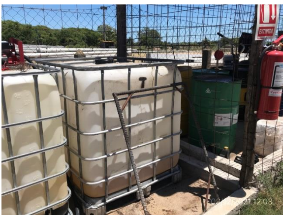
Ilustración 14 – P03, obrador principal. Sector envallado y techado para acopio y trasiego de lubricantes y productos químicos.
