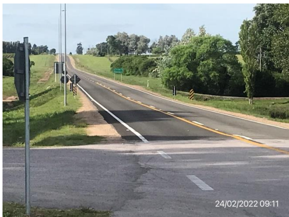
Ilustración 4 – P02, Fin de tramo. Ruta 12, progresiva 17K200. Empalme con Ruta 9.
