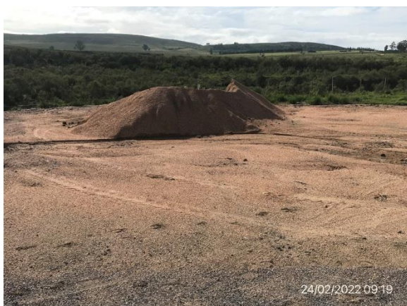
Ilustración 6 – P03, Acopio provisorio de materiales granulares. Ruta 12, progresiva 14K400.
