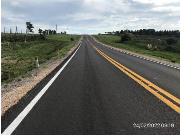
Ilustración 10 – Ruta 12, obras terminadas. Carpeta asfáltica nueva y señalización horizontal y vertical culminadas.
