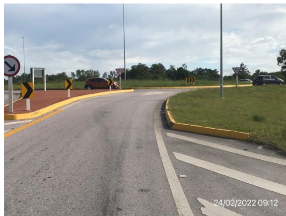
Ilustración 5 – P02, Fin de tramo. Ruta 12, progresiva 17K200. Empalme con Ruta 9.
