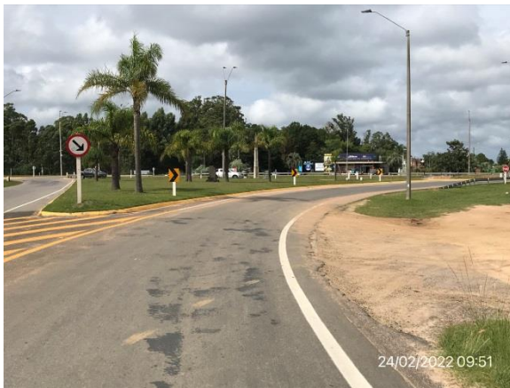
Ilustración 12 – P01, Inicio del tramo. Ruta 12, progresiva 0K000. Epalme con Ruta 10 - Interbalnearia
