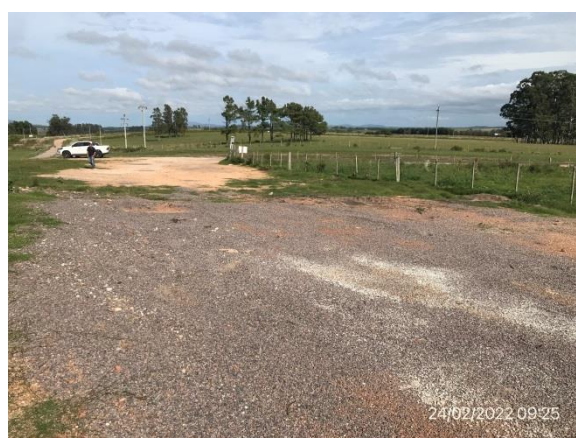
Ilustración 9 – P04, Obrador provisorio desmantelado. Explanada granular permanece como mejora del predio para uso de DNV.
